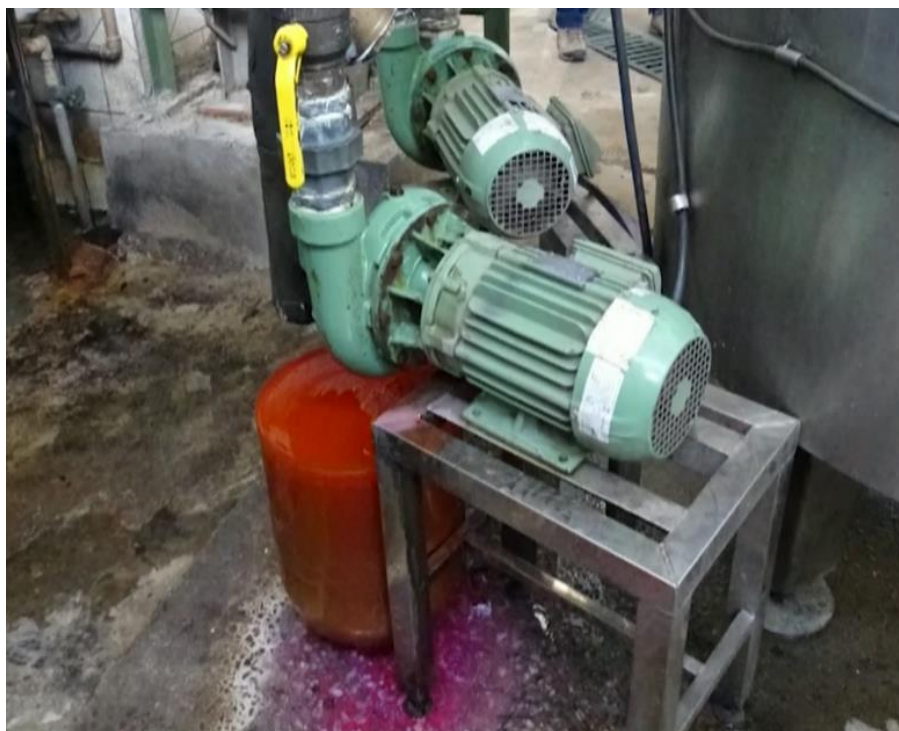
Figura 9: Bomba mecânica responsável pela movimentação do fluido anticongelante para o tanque 10 da cervejaria Backer, equipamento também apresentou vazamento constante do fluido na investigação feita pela Polícia Civil do estado de Minas Gerais no início de 2020. (FONTE: Adaptado de https://g1.globo.com/fantastico/noticia/2020/06/14/caso-backer-fantastico-mostra-com-exclusividade-como-a-contaminacao-das-ervejas-aconteceu.ghtml , 2020. )
