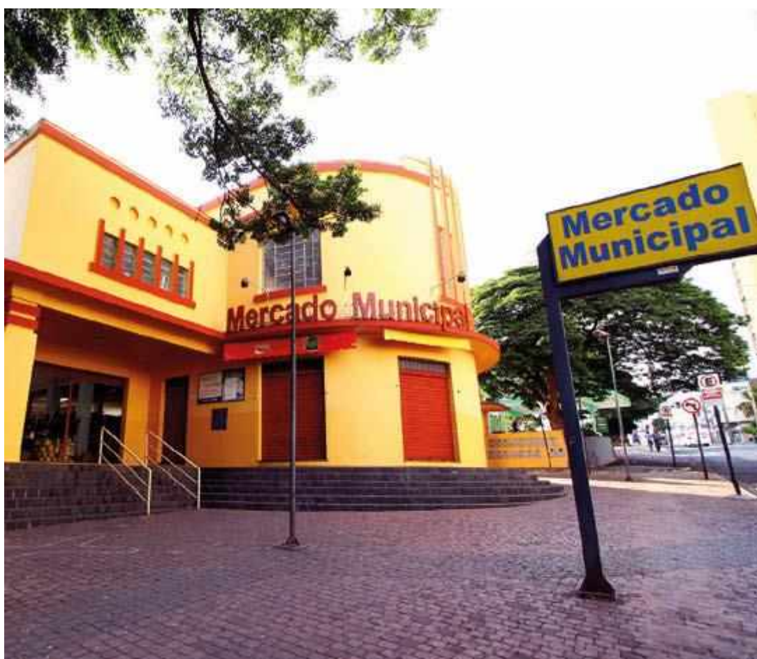
Figura 19 – Fotografia que mostra a fachada principal do Mercado Municipal
