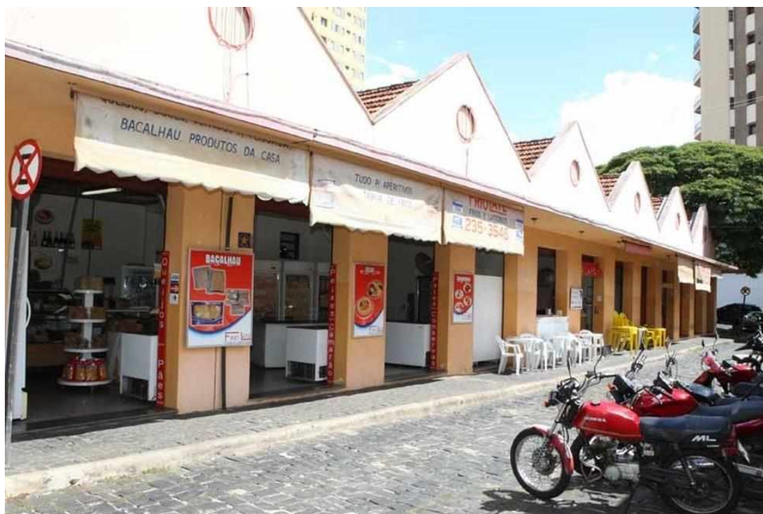
Figura 21 – Fotografia que apresenta a área interna do Mercado Municipal
