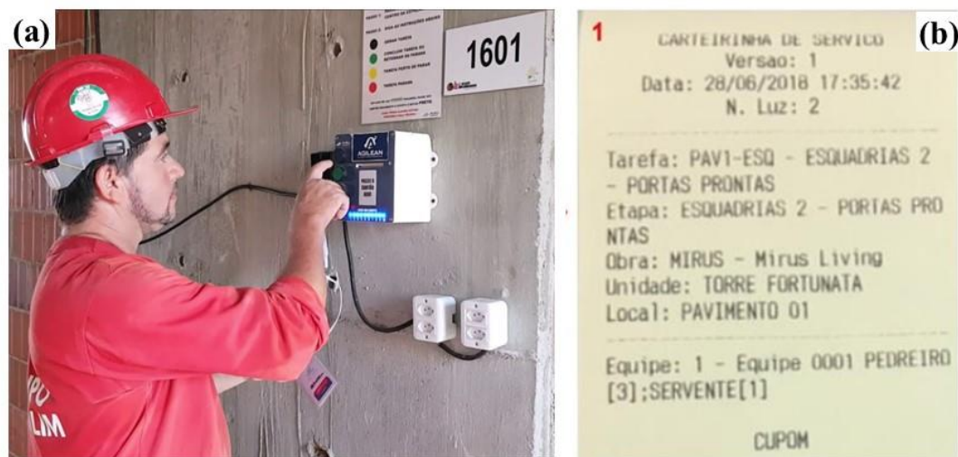
Figura 2: Estação Agilean Andon (a) instalada em obra (b) ficha de liberação de serviço para funcionário
