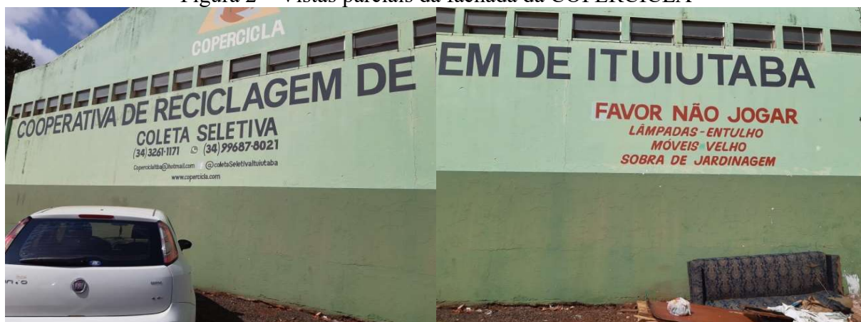
Figura 2 – Vistas parciais da fachada da COPERCICLA
