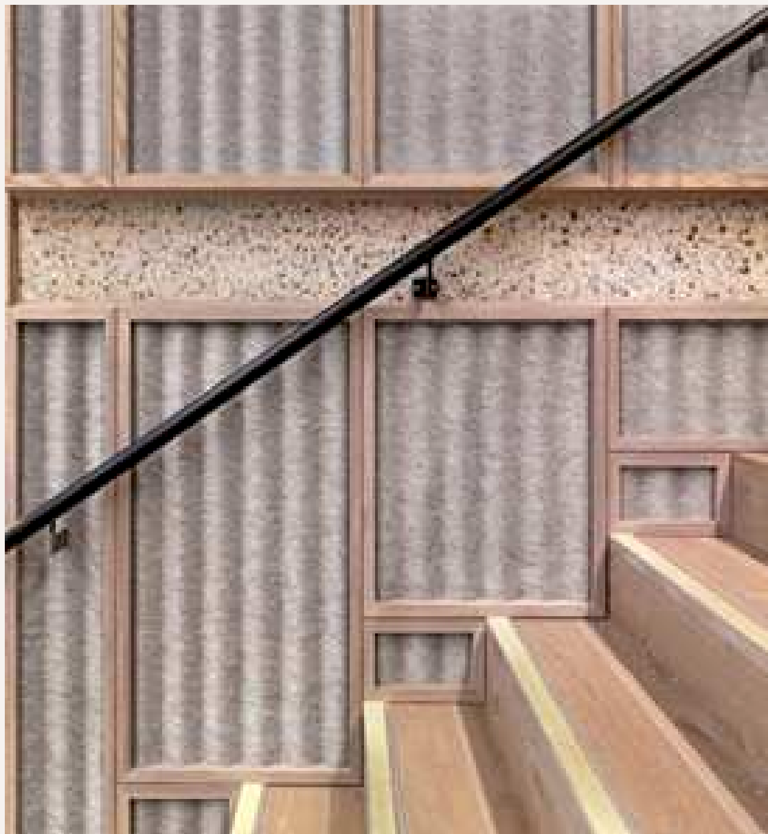
Figura 32 -Detalhes escada Paddington Works
