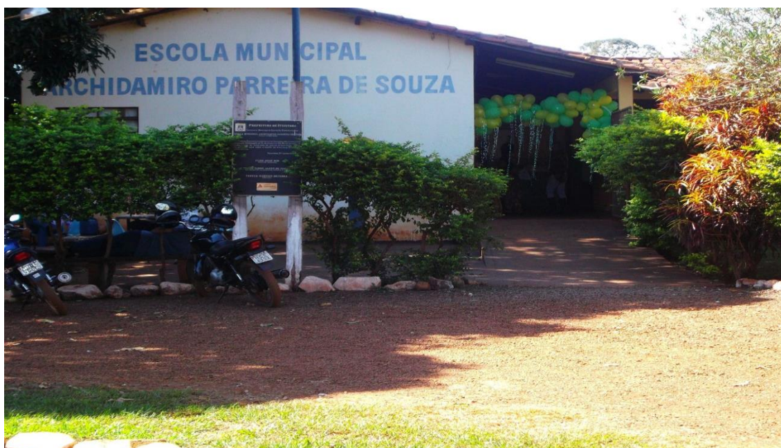
Figura 08: Fotografia da Escola Municipal Archidamiro Parreira de Souza
