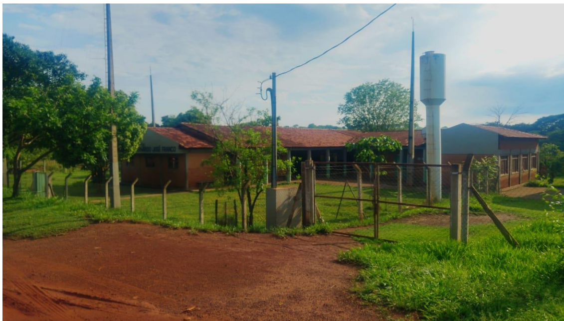
Figura 07: Fotografia da Escola Municipal Bernardo José Franco
