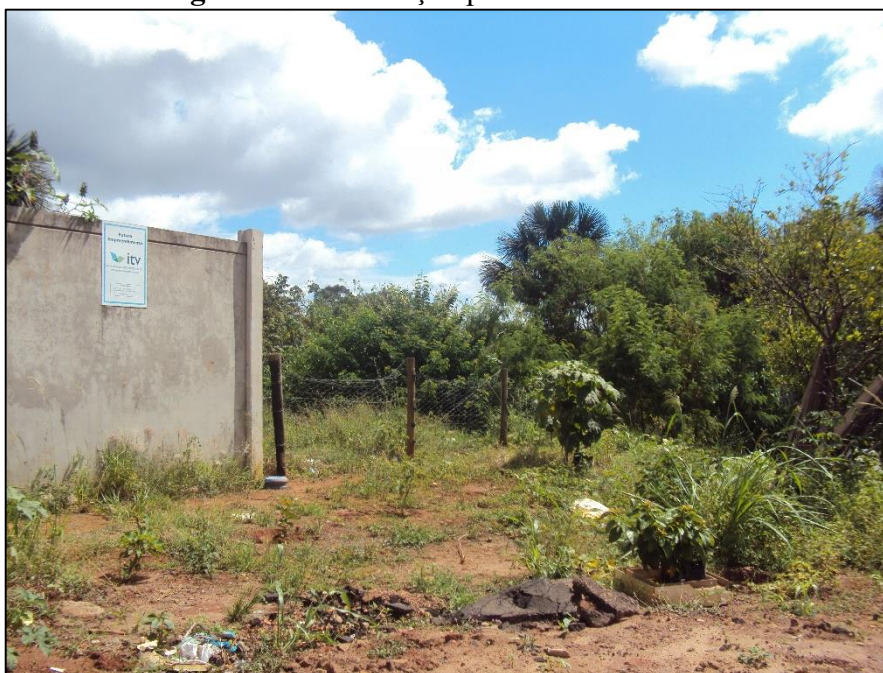
Figura 14: Construção próximo às nascentes
