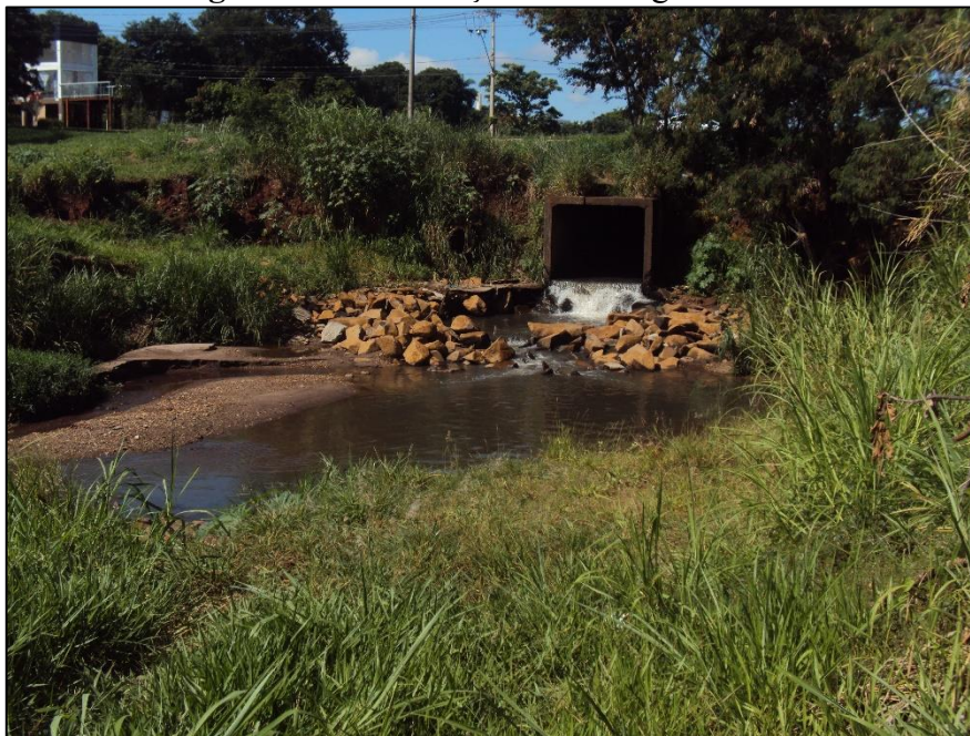
Figura 18: Canalização do Córrego do Óleo
