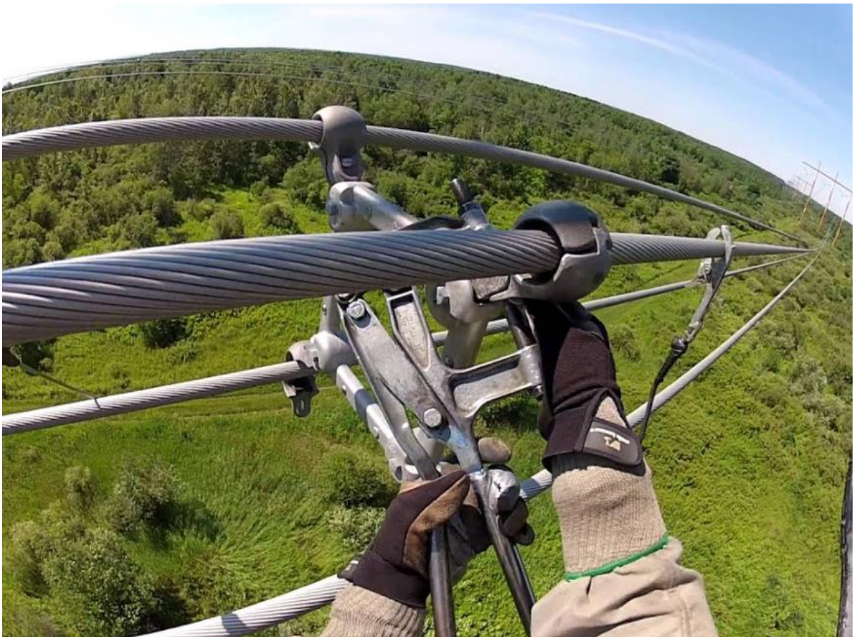
Figura 4 – Técnico utilizando ferramenta rebitadora. Fonte: ICMHI,2014
