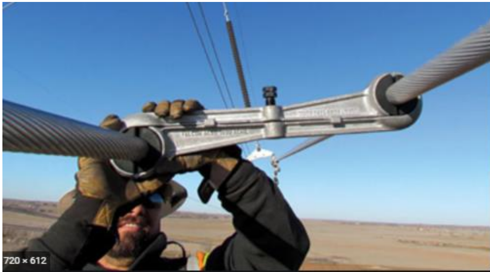
Figura 1 – Substituição manual de um espaçador de dois cabos. Fonte: ADL,2016
