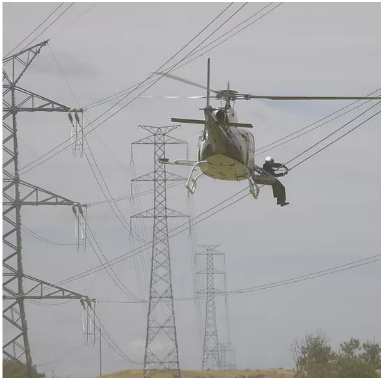
Figura 3 – Técnico fazendo a instalação de espaçador com auxílio de helicóptero. Fonte: Mitsa,2014
