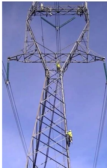
Figura 2 – Técnicos escalando torre de alta tensão. Fonte: TKO,2015
