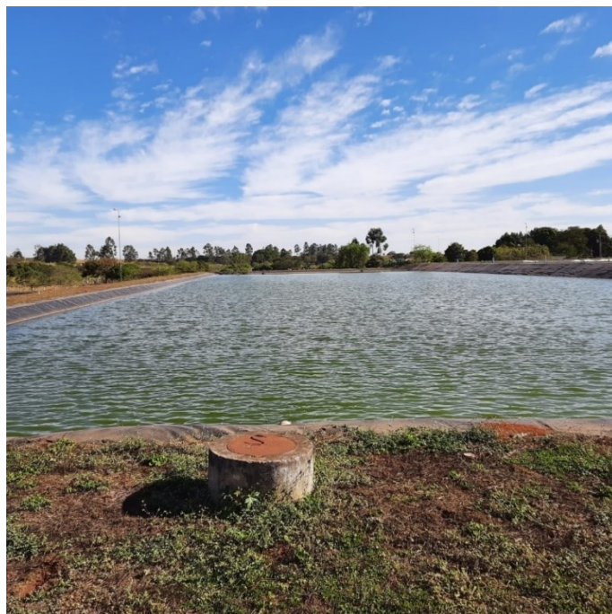
Figura 9 - Lagoa de maturação da ETE Industrial.
