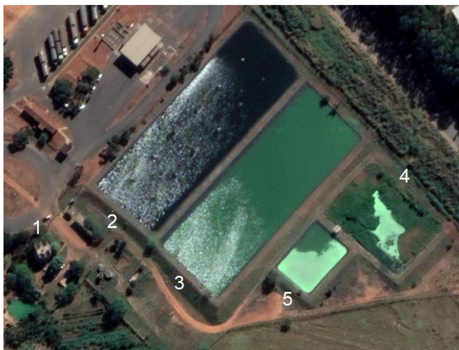
Figura 1 - ETE Novo Horizonte e ETE Industrial.
