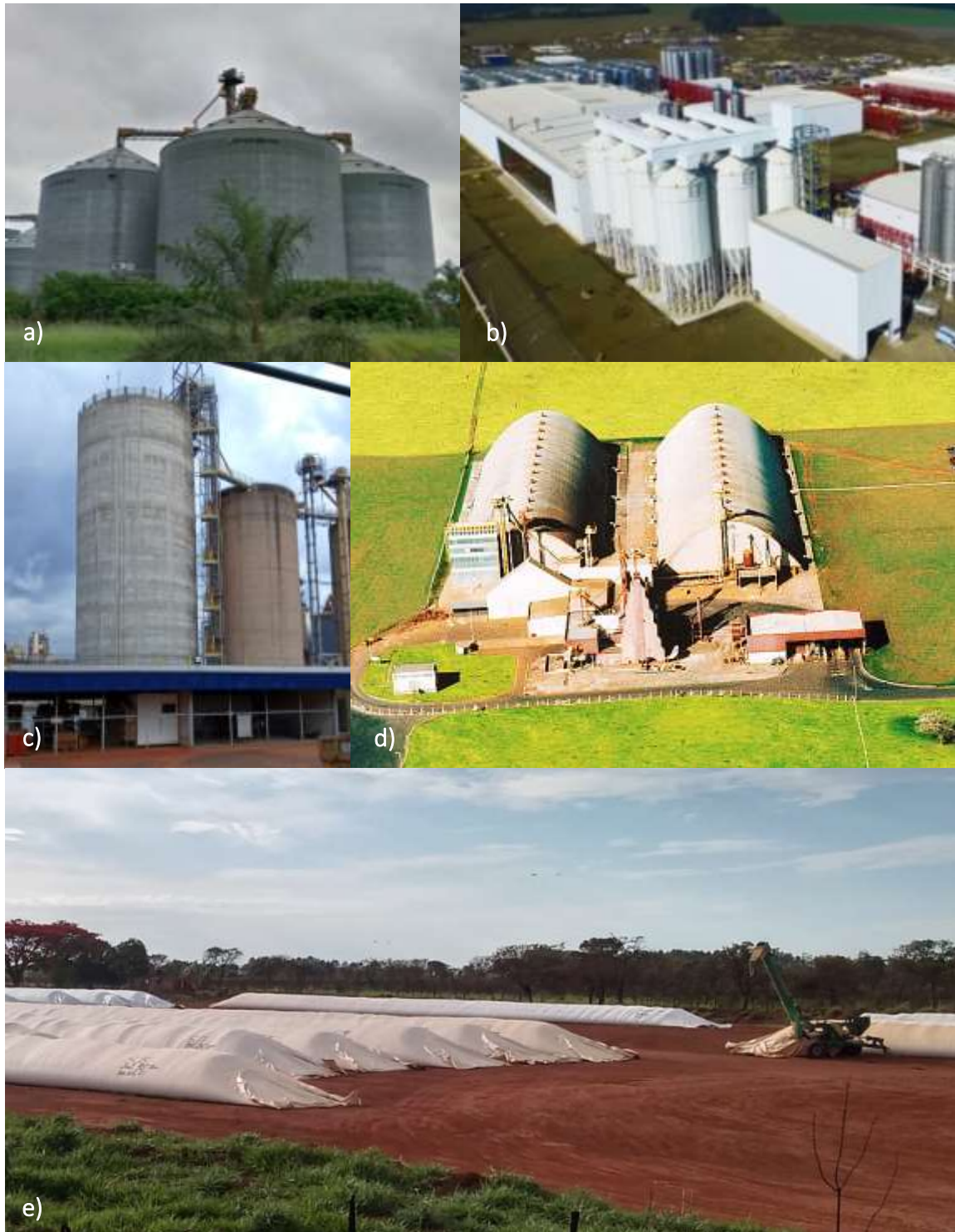
Figura 4 – Modelos diversos de silos utilizados no armazenamento de produtos agrícolas em Uberlândia. a) Silo metálico apoiado modelo Kepler Weber na Uberzem Ltda. b) Silo metálicos elevados da Ambev. c) Silo em concreto armado fundo elevado em indústria de processamento e esmagamento de soja. d) Graneleiro na ADM do Brasil. e) Silos bolsa para armazenagem de sorgo.
