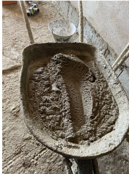
Figura 4 – Argamassa produzida na obra
