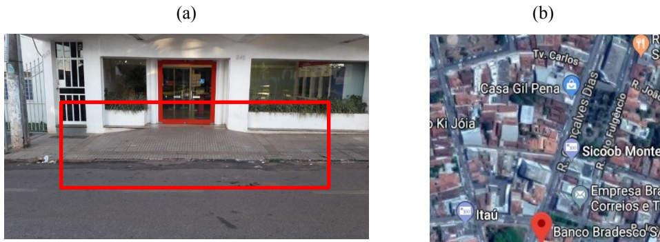
Figura 11 – Exemplo de irregularidade de calçada – (a) Retrato da ocorrência (em vermelho) (b) Localização da ocorrência na imagem do Google.
