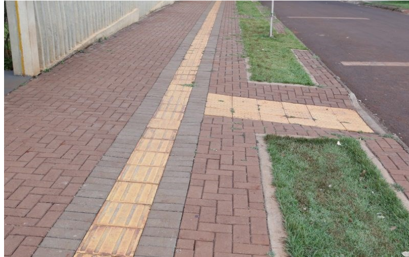
Figura 5 – Exemplo de calçada acessível
