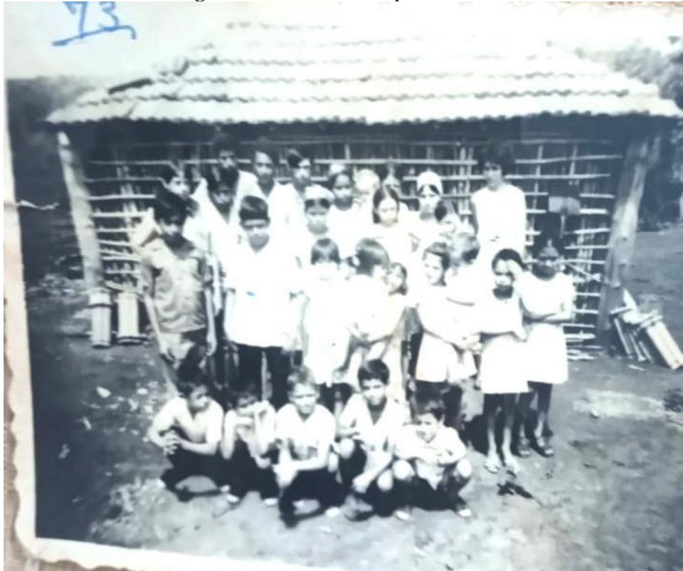
Figura 14: Escola Municipal Manoel Afonso Cancellia
