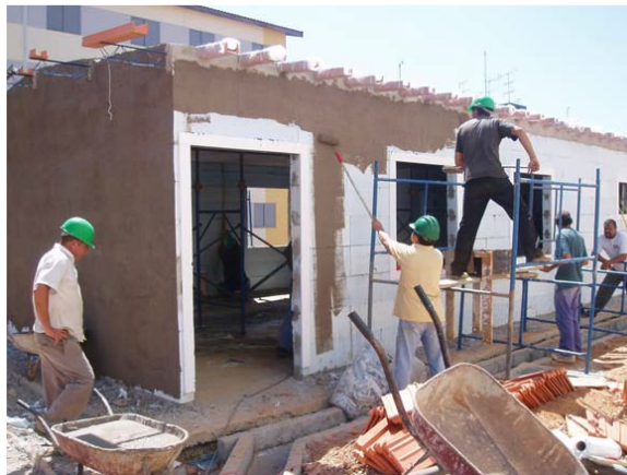
Figura 16 - Aplicação de chapisco rolado em paredes externas.
