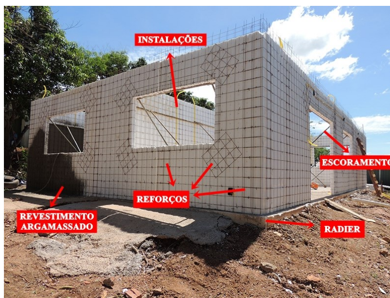
Figura 8 – Detalhamento de etapas do sistema monolítico.
