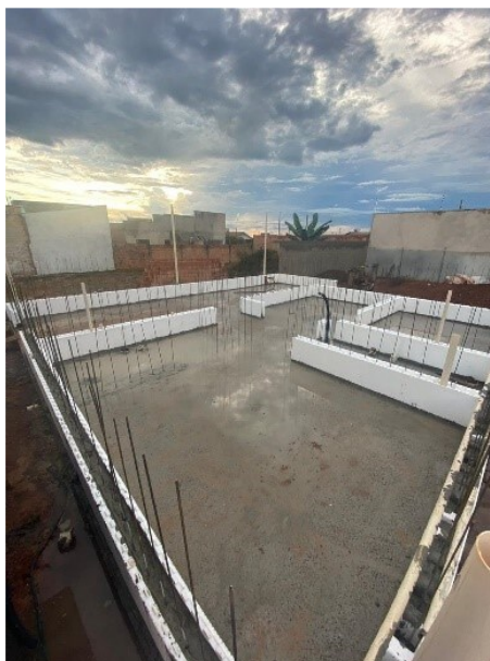
Figura 13- Primeira fiada de blocos ancorada na fundação.
