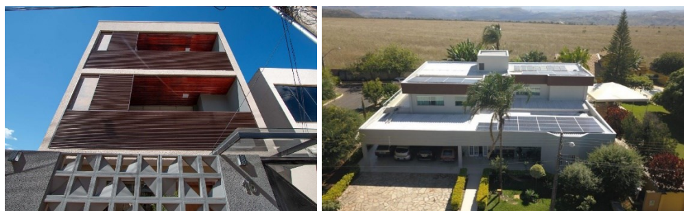
Figura 5 - Edificações construídas pela Baue com painéis monolíticos– (a) Edifício Vila Planalto; (b) Sobradinho.
