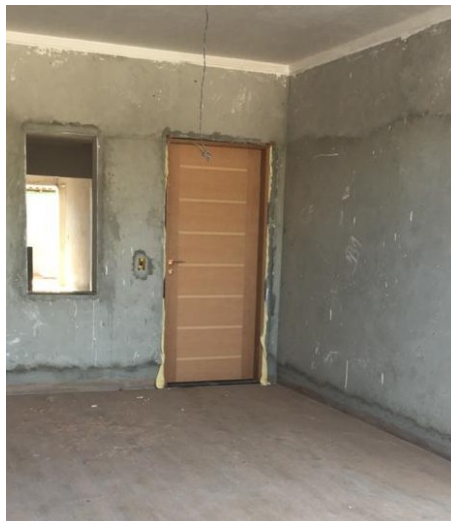
Figura 17 - Porta instalada com espuma expansiva.
