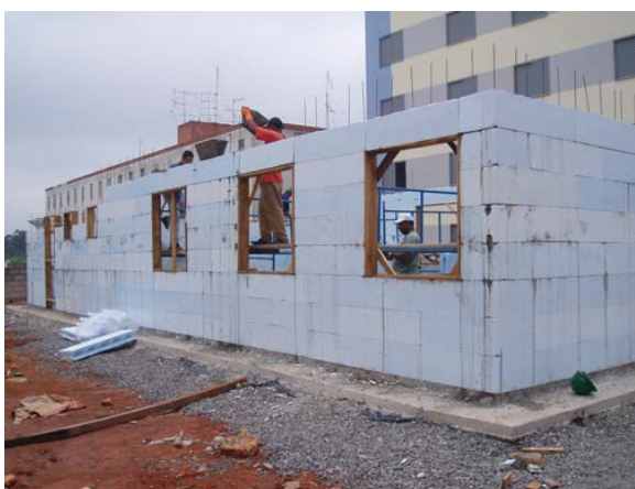
Figura 14 - Paredes do sistema concretadas.
