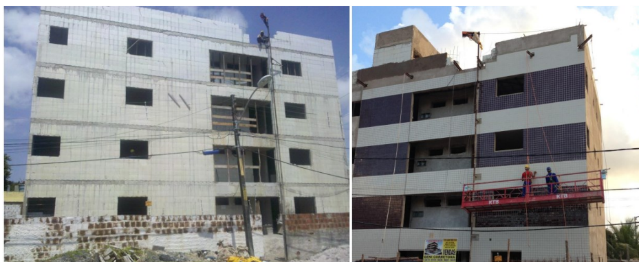
Figura 9 - Primeiro prédio de 4 pavimentos no sistema ICF realizado no país.
