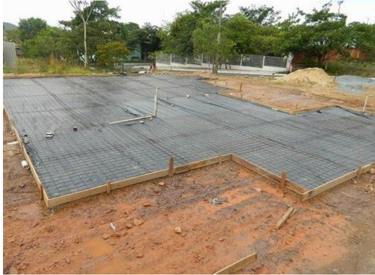
Figura 38: Execução de fundação radier
