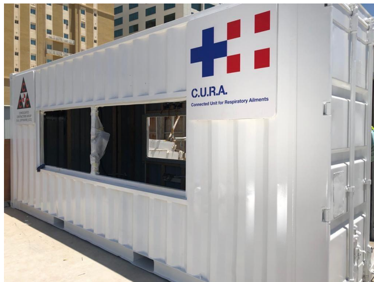
Figura 14: Container Projeto CURA sendo instalado no Qatar
