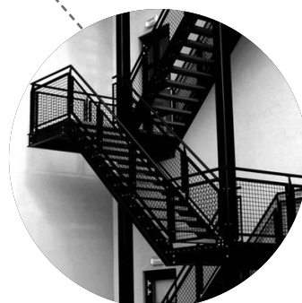
ref. escada metálica e guarda corpo
