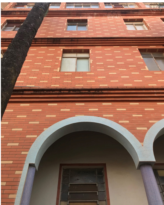
Revestimento das fachadas. Fonte: Autora.
