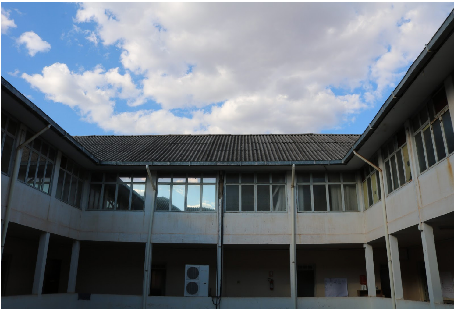
Detalhe do telhado. Fonte: equipe SeNEMAU.
