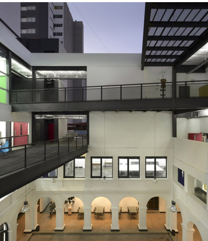
Pátio interno / Escola de Artes Visuais. Fonte: Archdaily.
