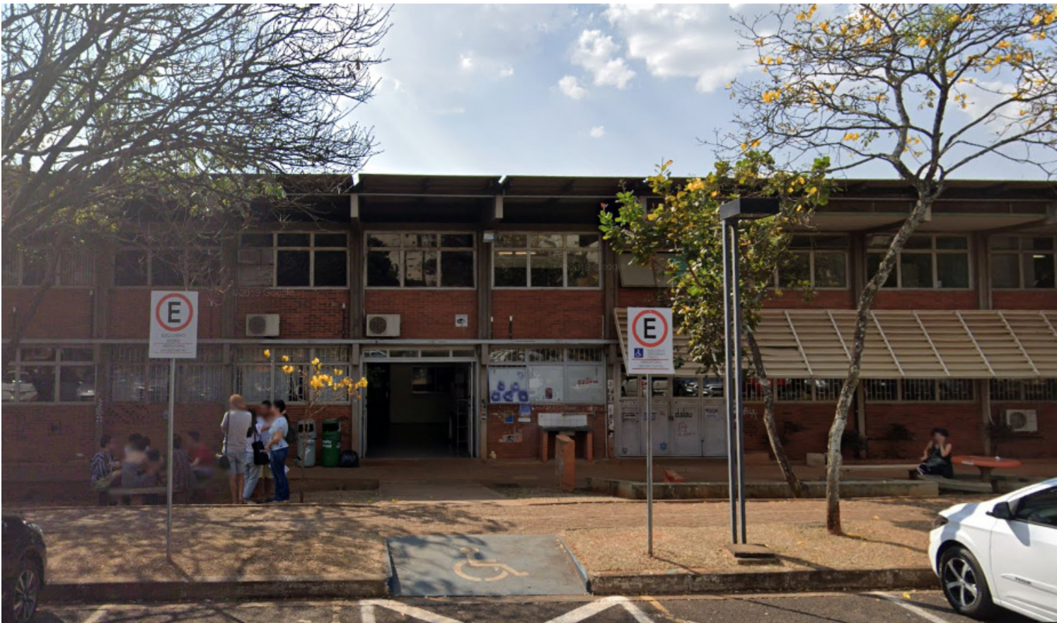
Bloco I, UFU. Fonte: Google Maps.
