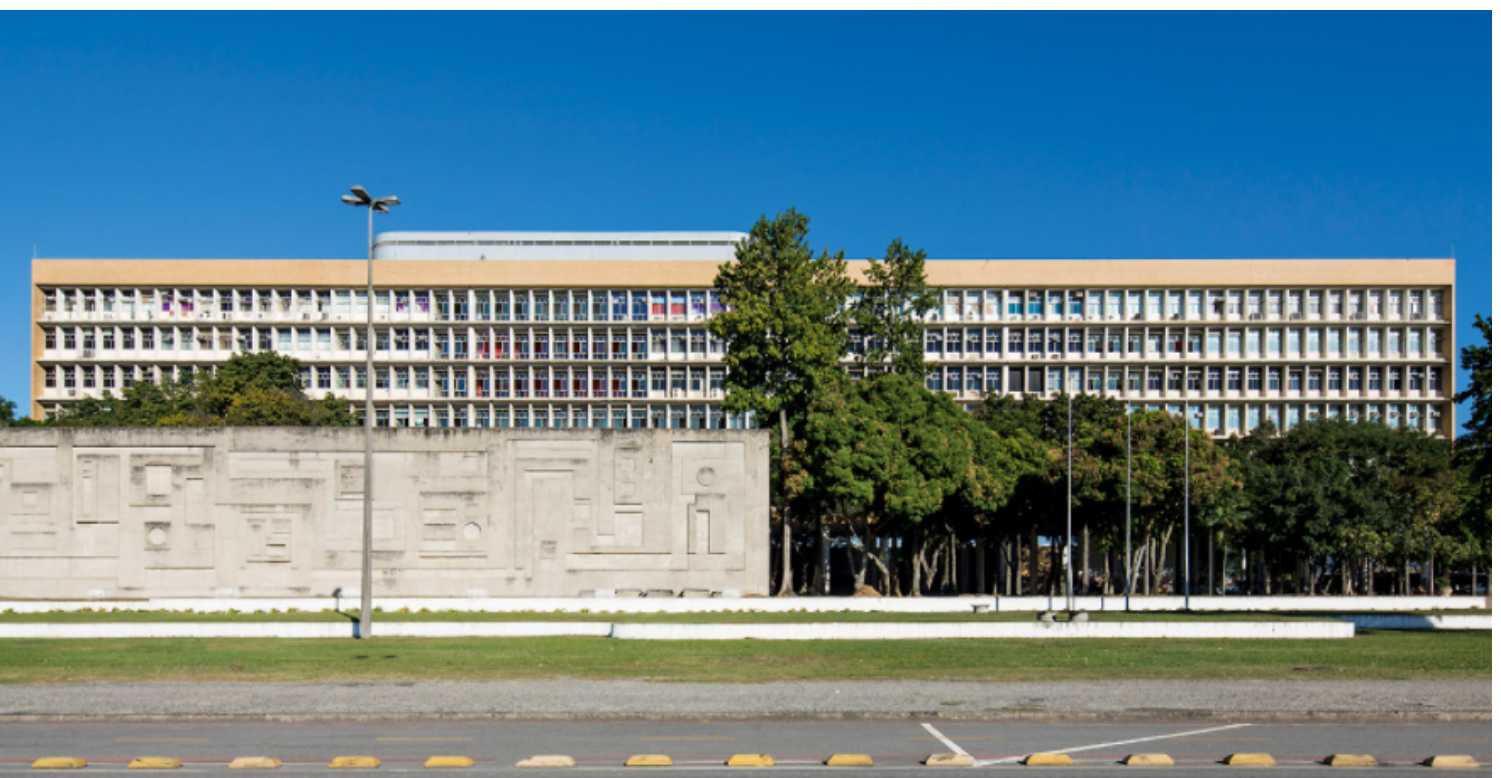
Faculdade de Arquitetura da UFRJ. Fonte: http://arqguia.com/obra/edificio-reitoria-ufrj/?lang=ptbr
