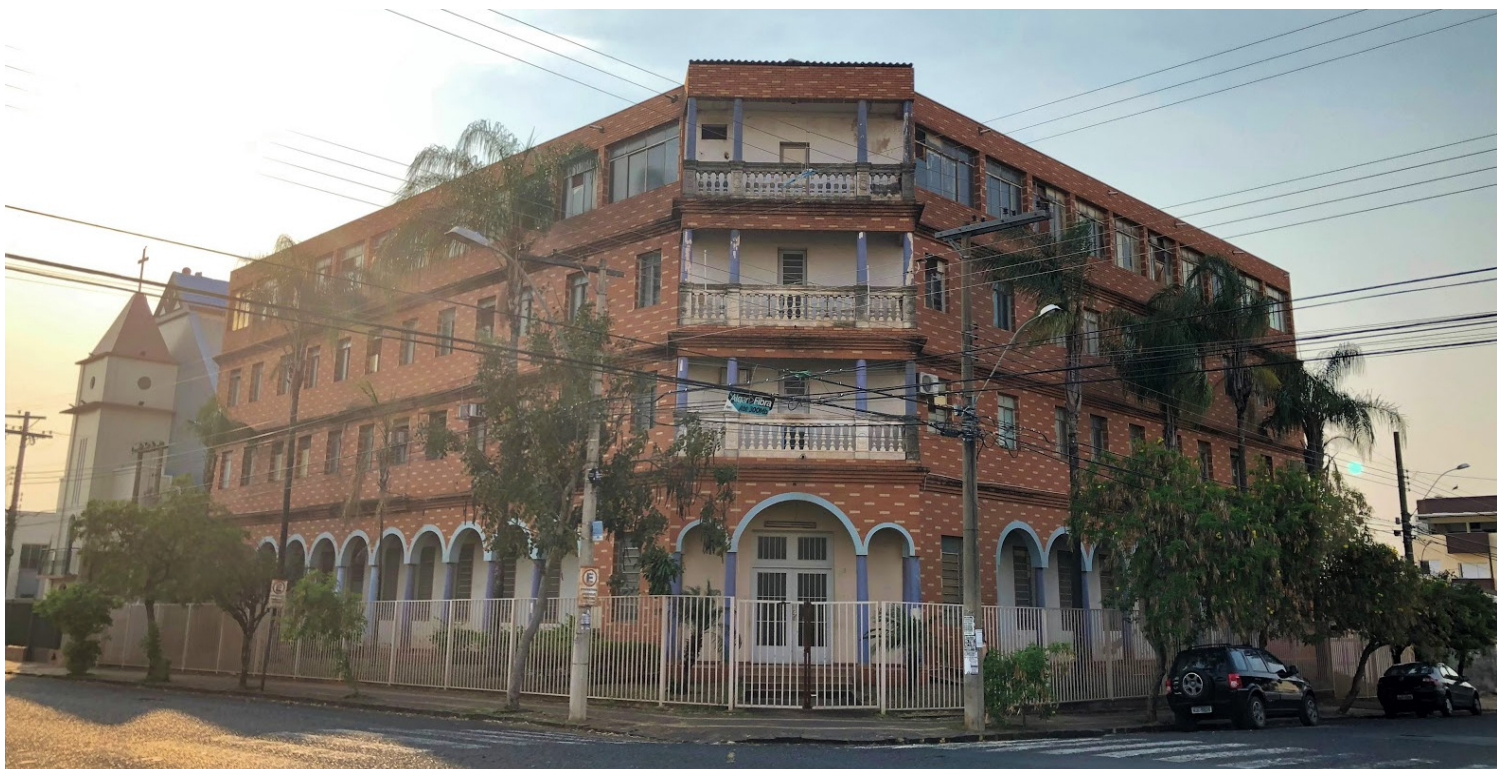
Fachadas do edifício preexistente. Fonte: Autora.
