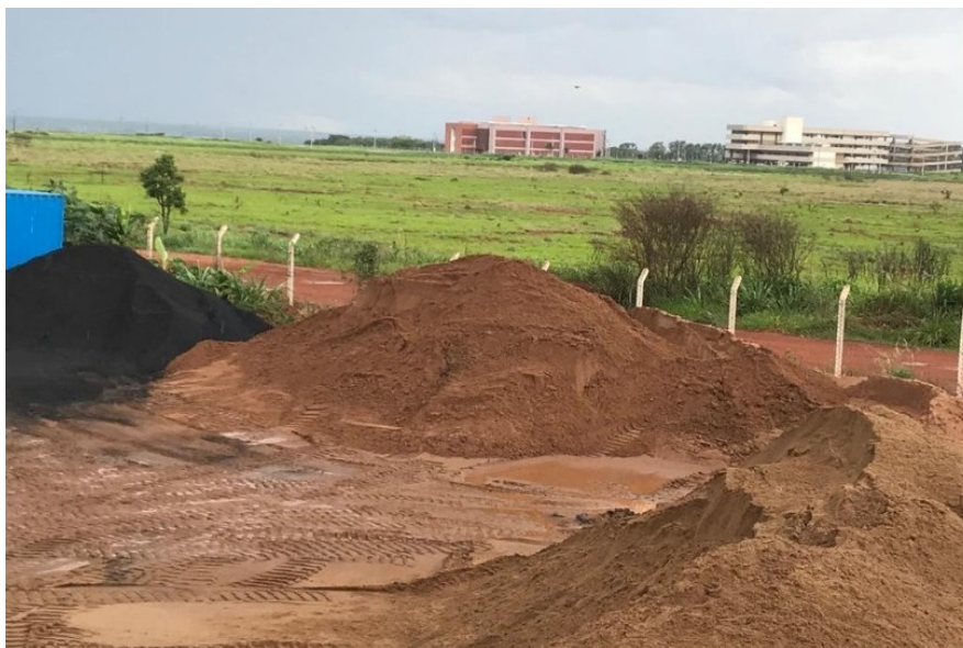
Figura 11 – Armazenamento dos agregados miúdos
