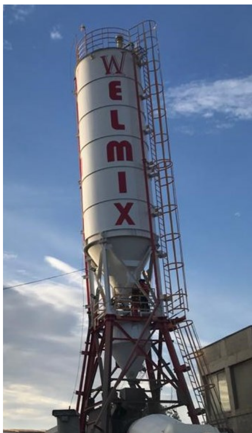
Figura 9 – Local de armazenamento do cimento (Silo)
