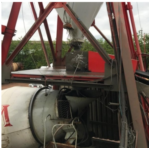
Figura 17 – Local de descarga dos materiais
