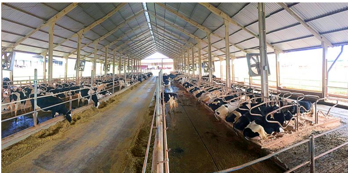
Figura 2 - Estrutura interna de um Free Stall
