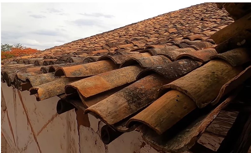
Imagem 16 – Telhado de telha cocha
