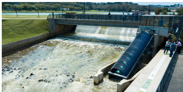
Figura 2.5 – Turbina de Arquimedes instalada no Parque Barigui, em Curitiba. Fonte: ABRAPCH (2019).
