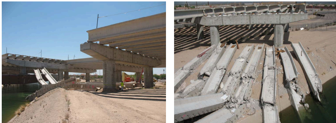
Figura 1.1 – Colapso de vigas no Arizona (a) (b)
