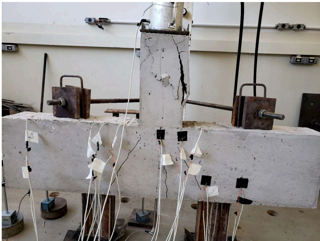
Figura 36 – Ruptura do bloco B20S por esmagamento do concreto no topo do pilar
