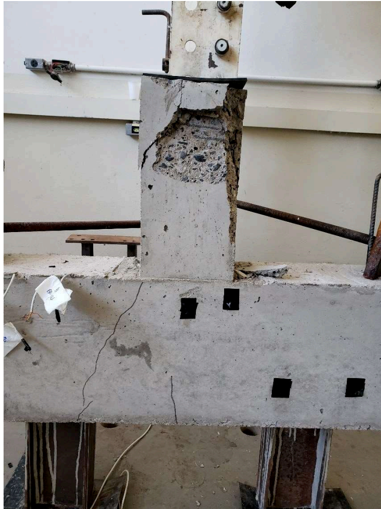
Figura 32 – Ruptura do bloco B16-12,5S por esmagamento do concreto no topo do pilar
