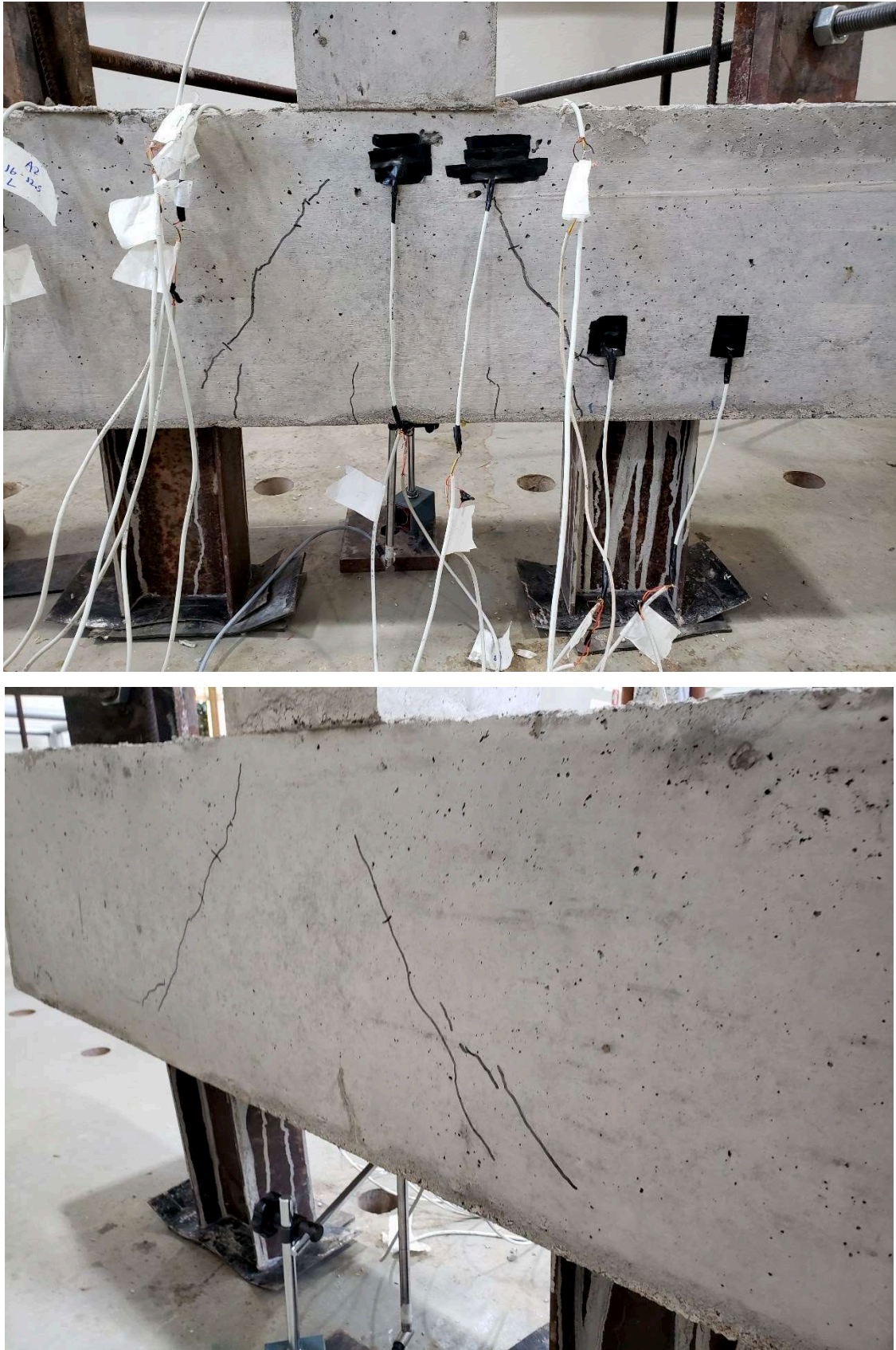
Figura 33 – Propagação das fissuras no bloco B16-12,5L
