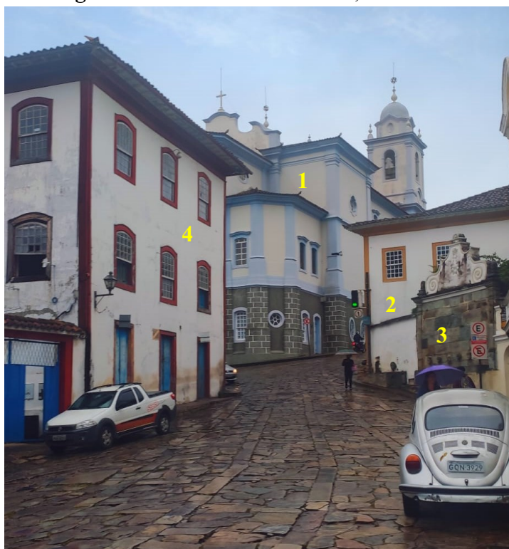
Figura 01 - Rua Macau do Meio, Diamantina – MG
