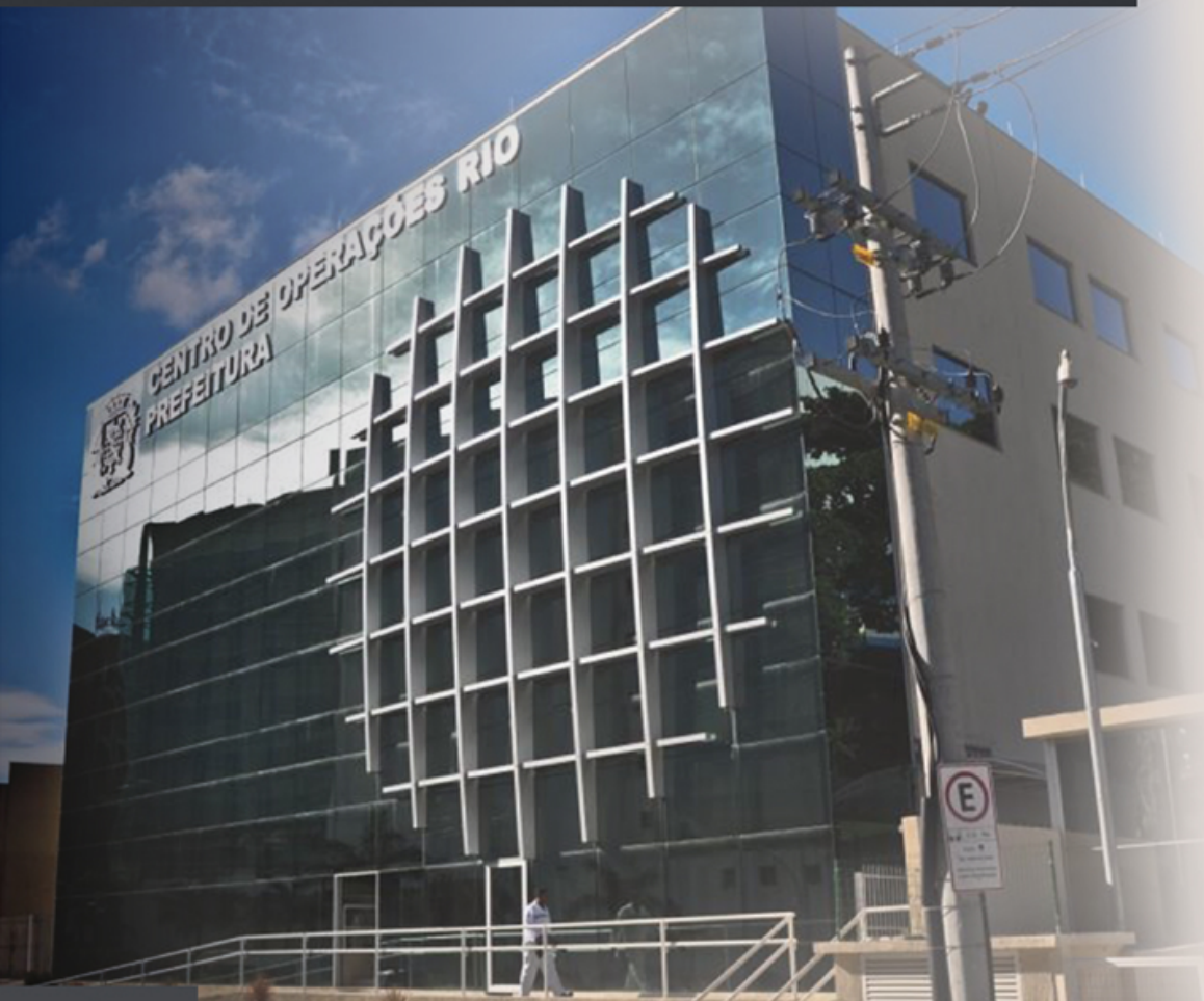
Figura 8- Sede do Centro de Operações Rio. Fonte: Centro de Operações Rio, 2018.
