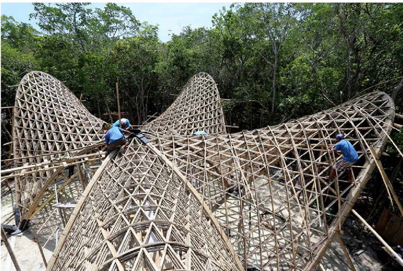
Figura 48: Construção estrutura Templo de Yoga Luum. Fonte: DesignBoom.
