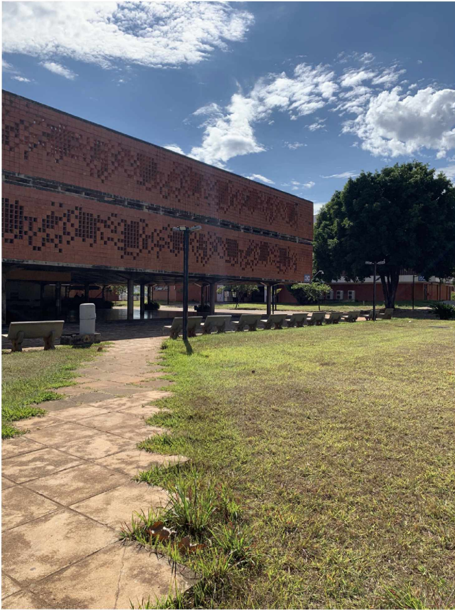
Figura 98: Piso existente. Fonte: Autora, 2021.
