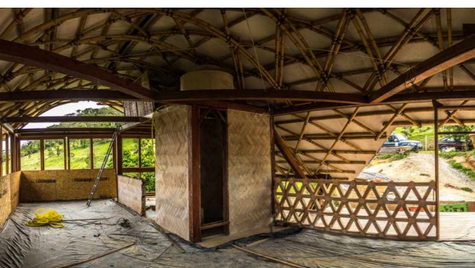
Figura 31: Projeto em fase de execução. Fonte: Ciclo Vivo
