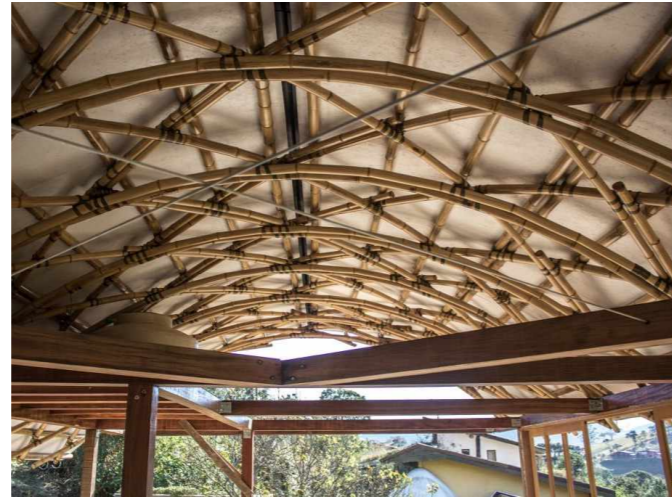
Figura 25: Gridshell em bambu que forma a estrutura da cobertura. Fonte: Ciclo Vivo.
