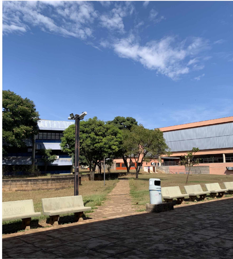
Figura 99: Piso existente. Fonte: Autora, 2021.
