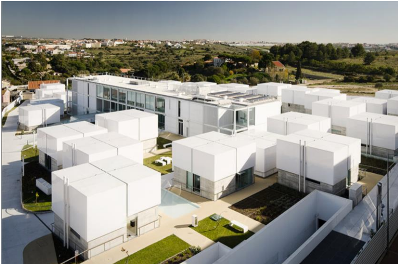
Figura 39: Vista das residências e do bloco de apoio do Complexo Social de Alcabideche. 2014. Fonte: Homify.
