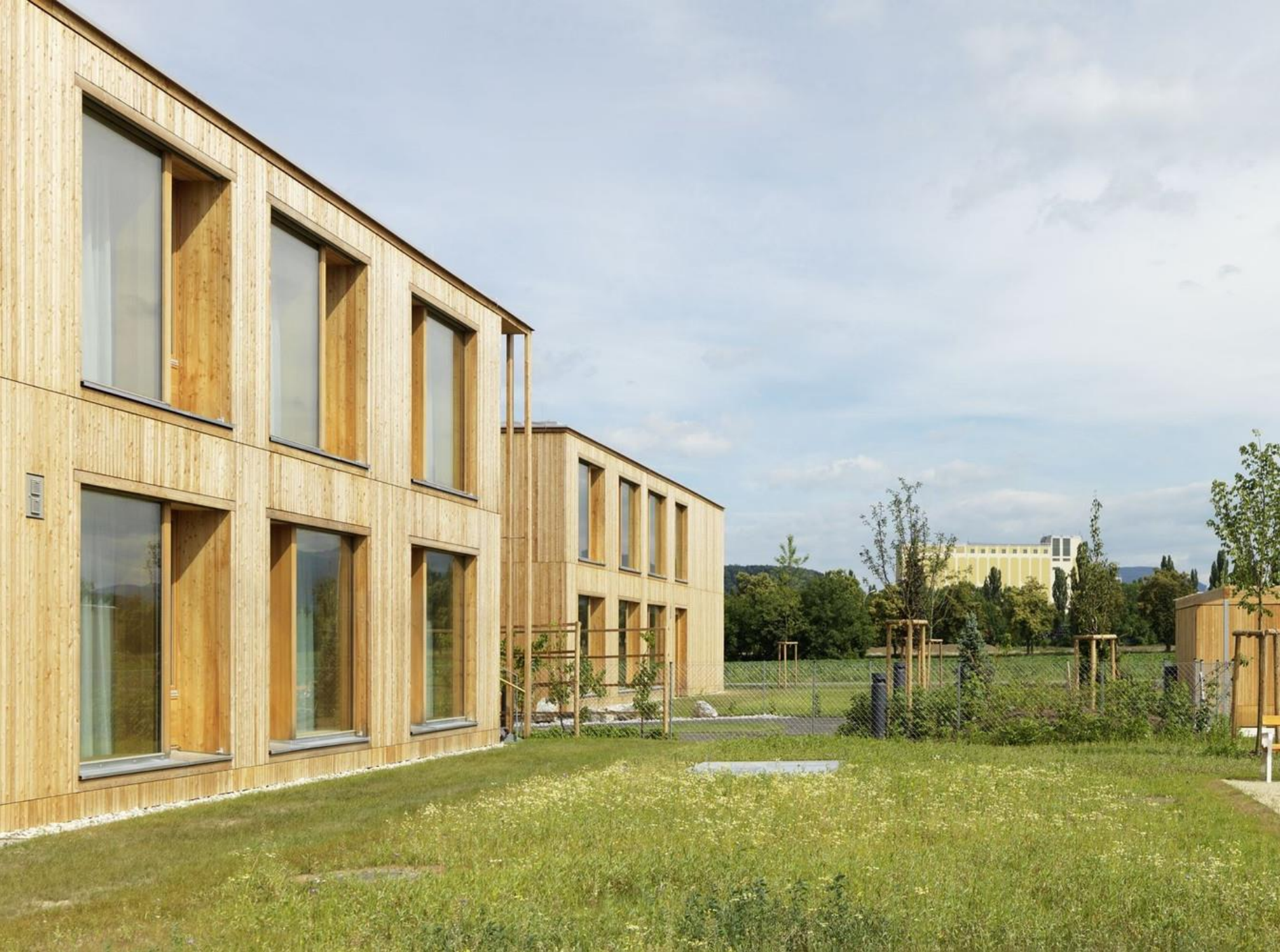
Figura 59: Vista externa da edificação - Conexão entre exterior e interior por meio das aberturas em vidro. 2014 . Fonte: ArchDaily
