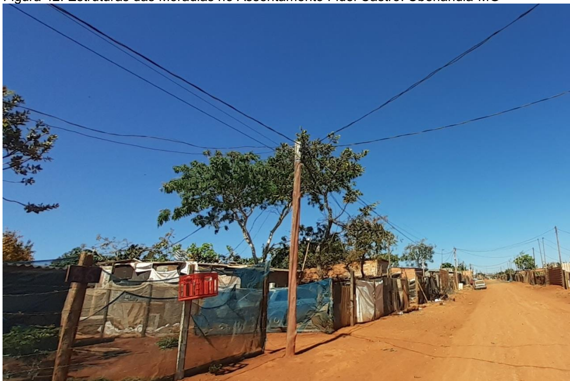
Figura 42: Estruturas das Moradias no Assentamento Fidel Castro. Uberlândia-MG
