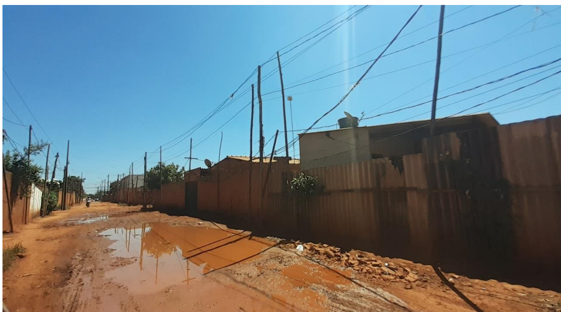
Figura 36: Uberlândia-MG: Condições de circulação nas ruas do Assentamento Maná. 2020
