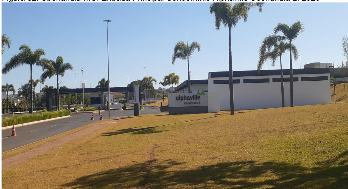
Figura 32: Uberlândia-MG: Entrada Principal Condomínio Alphaville Uberlândia 2. 2020
