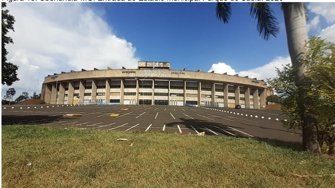
Figura 13: Uberlândia-MG: Entrada ao Estádio Municipal Parque do Sabiá. 2020
