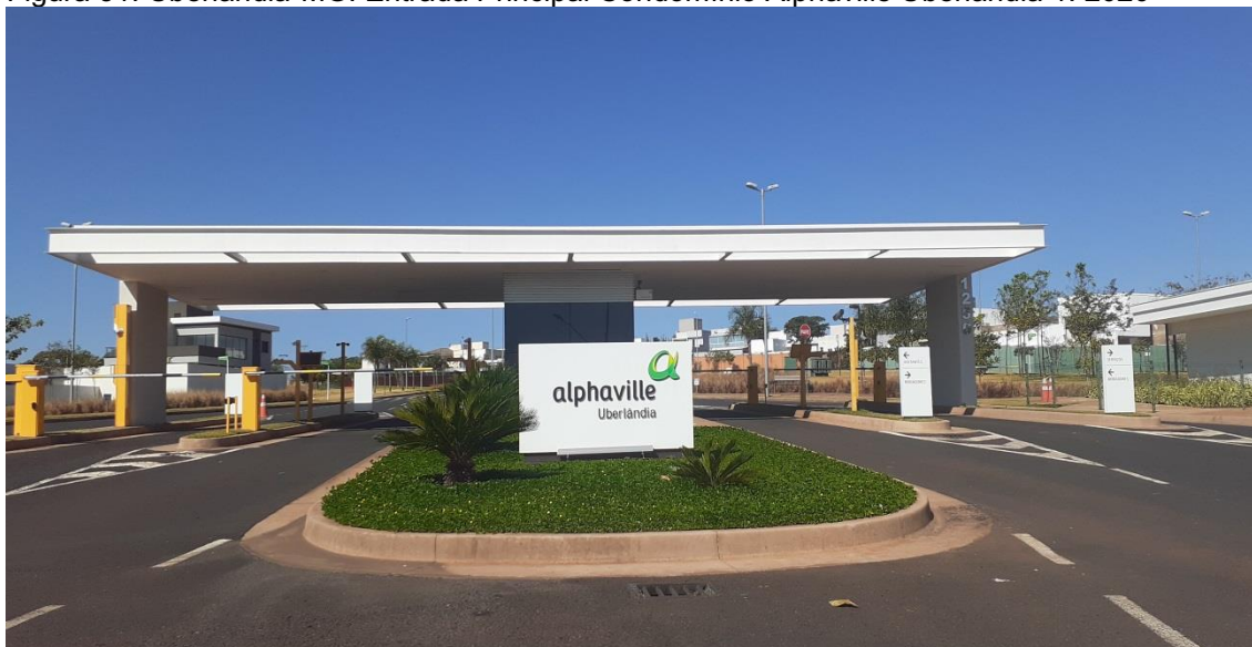
Figura 31: Uberlândia-MG: Entrada Principal Condomínio Alphaville Uberlândia 1. 2020
