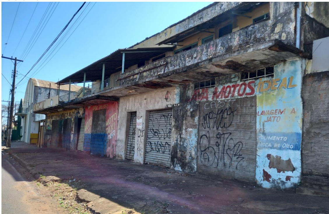
Figura 49: Uberlândia-MG: Estabelecimentos Comerciais abandonados no bairro Custódio Pereira. 2021
