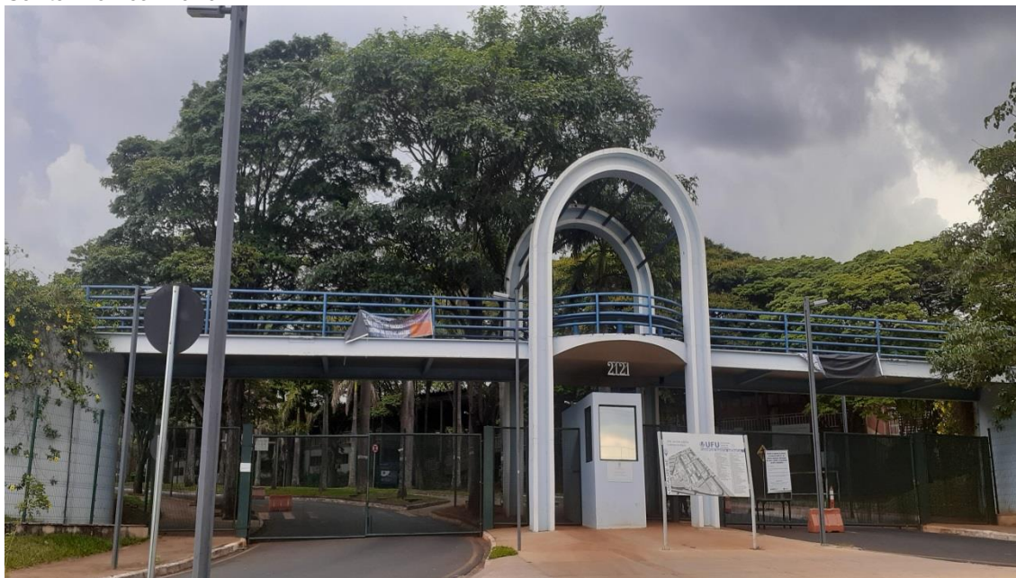
Figura 12: Uberlândia-MG: Entrada Principal da Universidade Federal de Uberlândia. Campus Santa Mônica. 2020
