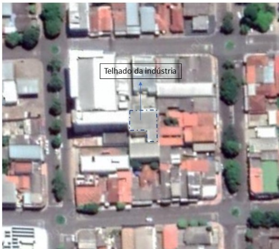
Figura 11 – Imagem aérea do telhado
