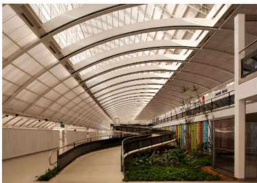
Estrutura metálica que possibilita a abertura zenital. (Retirado de http://arqguia.com . Foto tirada por: Leonardo Finotti. Data de acesso: 23/08/2020.)
