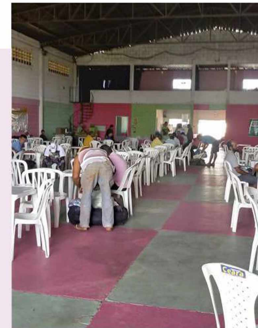
Estrutura em concreto, tesoura metálica e tijolo vazado abaixo da cobertura. (Retirado de https://www.facebook.com . Data de acesso em: 11/08/2020.)
