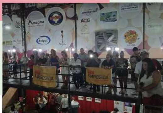
Mezanino em estrutura metálica e pilares metálicos treliçados. (Retirado de Google Maps. Foto tirada por José Roberto Jotaerre. Data de acesso: 12/08/2020.)
