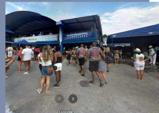
Cobertura em estrutura metálica e telha de alumínio. (Retirado de: Google Maps. Foto tirada
