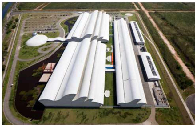
Imagem aérea. Sheds locados de acordo com a orientação solar. (Retirado de http://arqguia.com . Foto tirada por: Leonardo Finotti. Data de acesso: (23/08/2020.)
