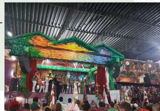
Cobertura em treliça metálica com telhas de alumínio. (Retirado de: Google Maps. Foto tirada por Adelsio Reis. Data de acesso: 12/08/2020)
