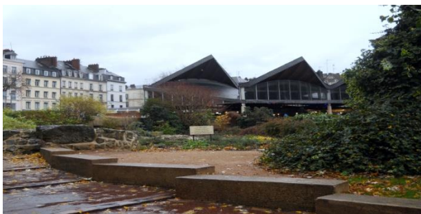
Fig. 93 - Vista da praça, com a placa onde foi colocada a fogueira que matou Joana D’Arc Fonte: Blog O Direto de Paris (2013)
