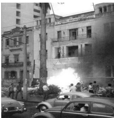
Fig. 13 – Prédio da UNE incendiado Fonte: Site da UNE (2014)
