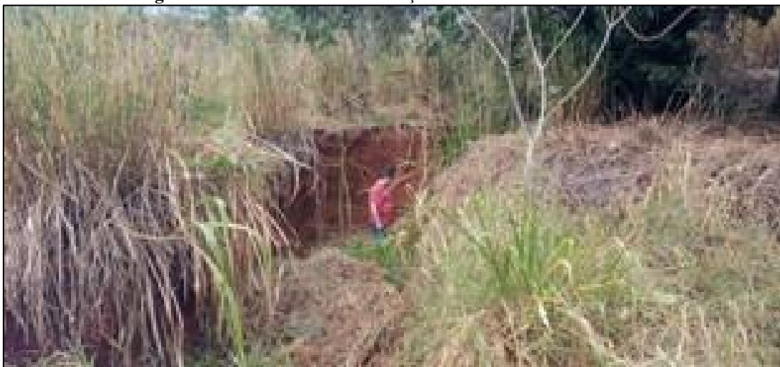
Figura 05: Erosão em forma de Voçoroca no Bairro Cidade Jardim
