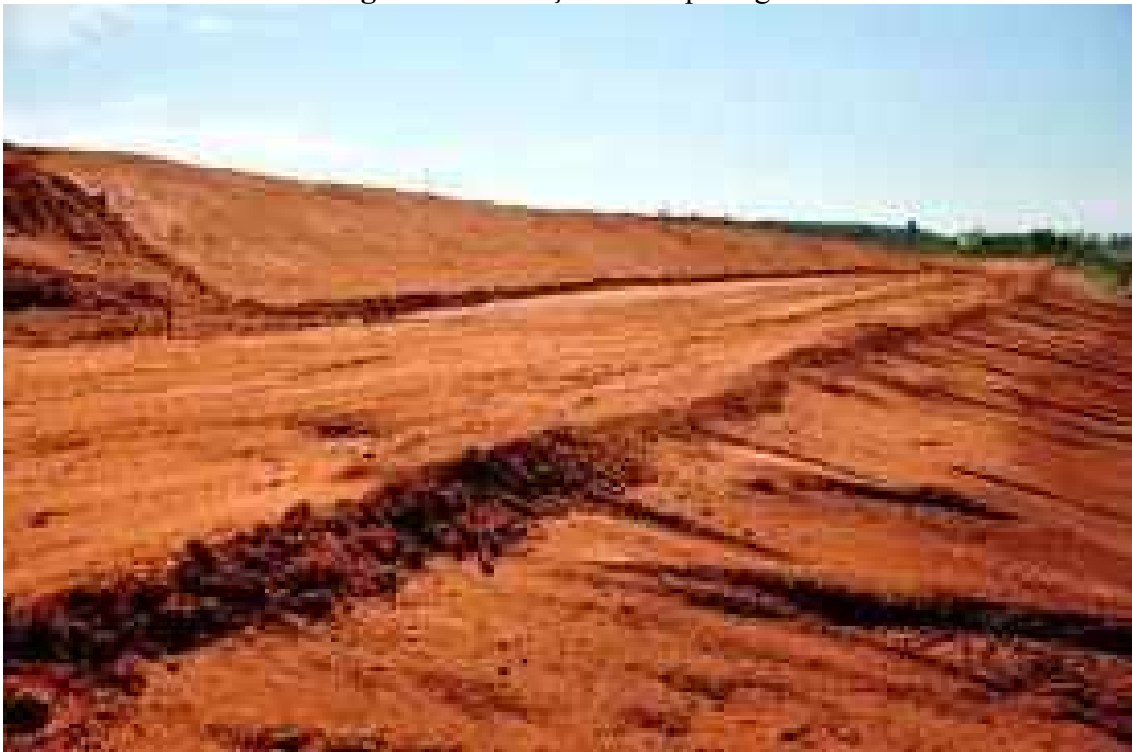
Figura 41: Serviço de terraplanagem
