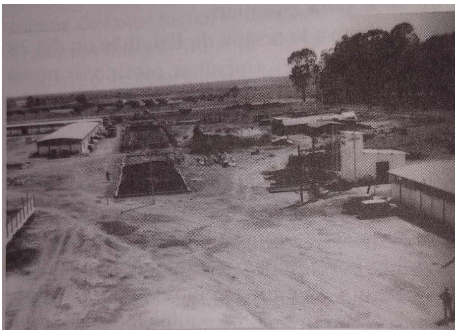
Figura 12 – Construção do pavilhão de comando do Batalhão em Araguari, 1965.
