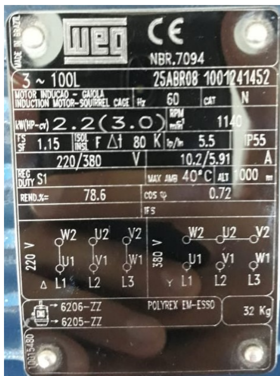
Figura 21 - Dados de placa MIT 3 CV 6 polos (MOTOR 03)
