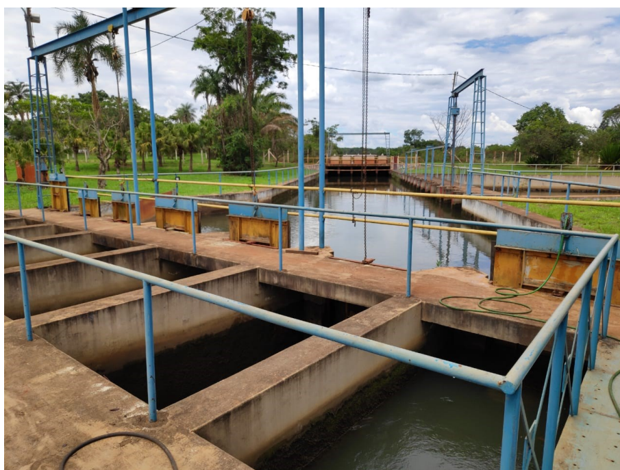
Figura 6 – Canal de captação da água bruta da ETA Sucupira.
