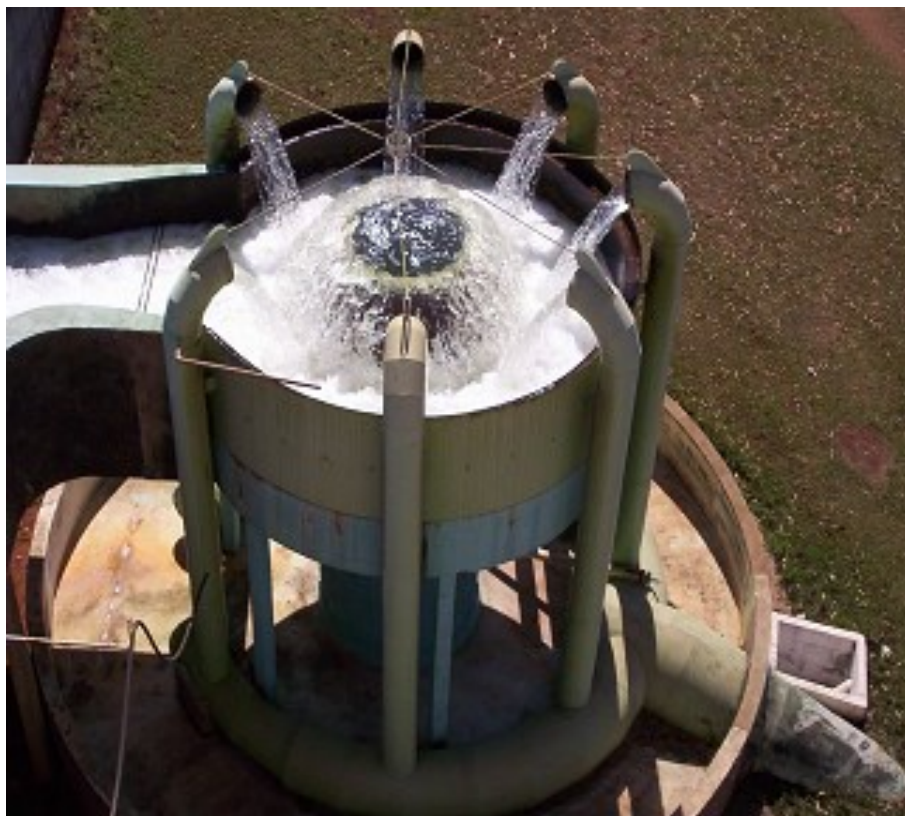
Figura 11 – Ponto de chegada da água bruta para o tratamento, denominado Bolo de Noiva
