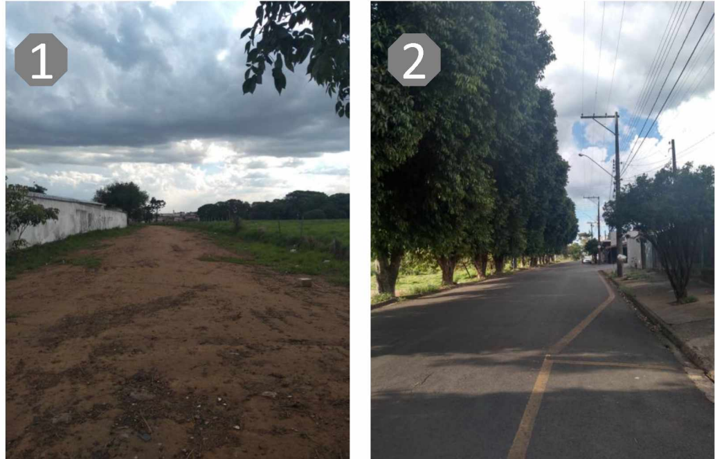
Figura 61: Imagem da rua com e sem asfalto. Fonte: Autora, 2020.
