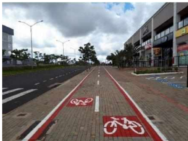
Figura 24: Calçadas com ciclovia do bairro Grana Marileusa
