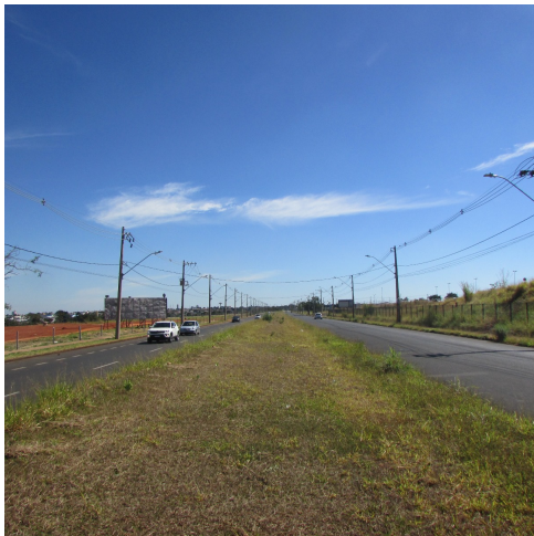
c) C3 - Av. Rui de Castro Santos. Transformador a esquerda.
