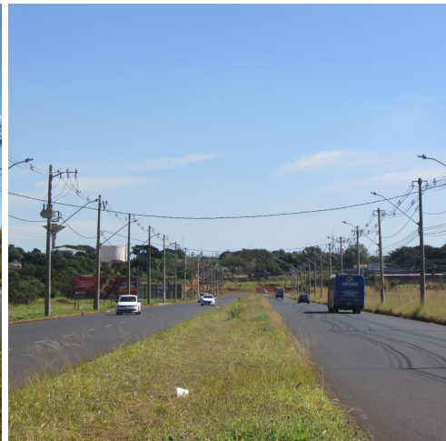
d) C4 - Av. Rui de Castro Santos. Transformador a esquerda.
