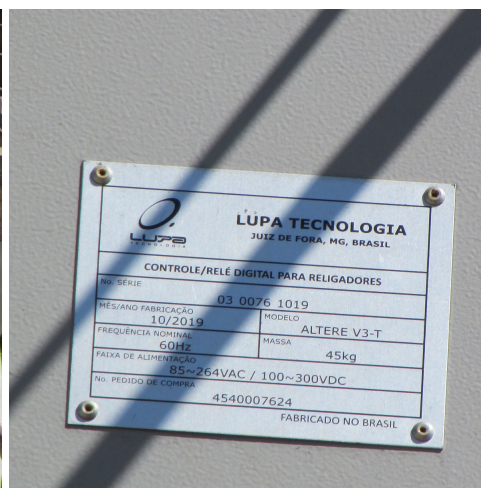
d) Placa da unidade de controle do Religador 2
