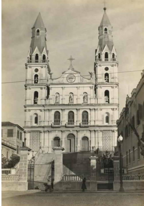
Imagem 4 - Estado do Rio Grande do Sul - Igreja de Nossa Senhora das Dores
