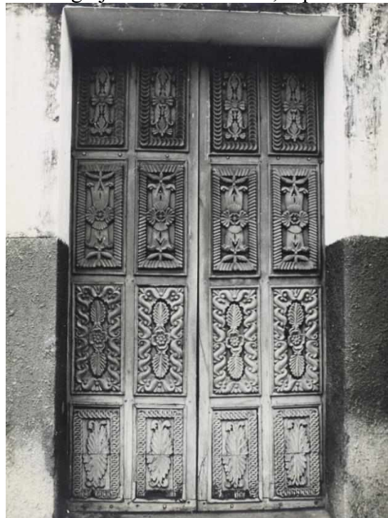
Imagem 10 - Estado do Piauí - Igreja de São Benedito, especificamente as respectivas portas
