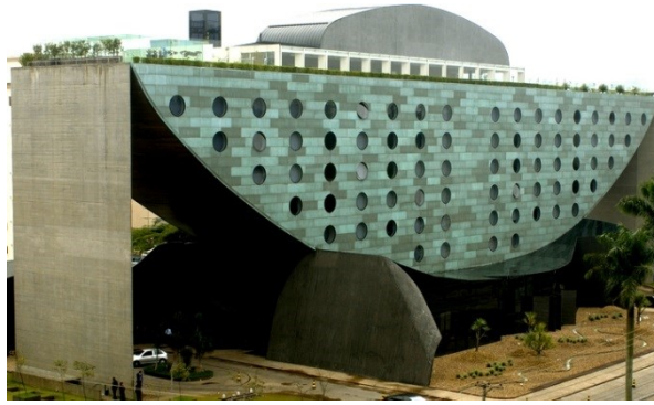
Figura 22 - Estrutura do "Hotel Unique"; Fonte: http://www.coppermax.com.br/
