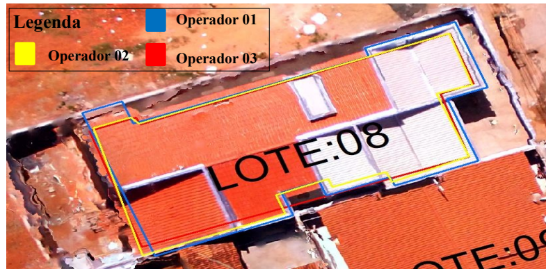
Figura 17 – Construções sem beiral - Lote 08
