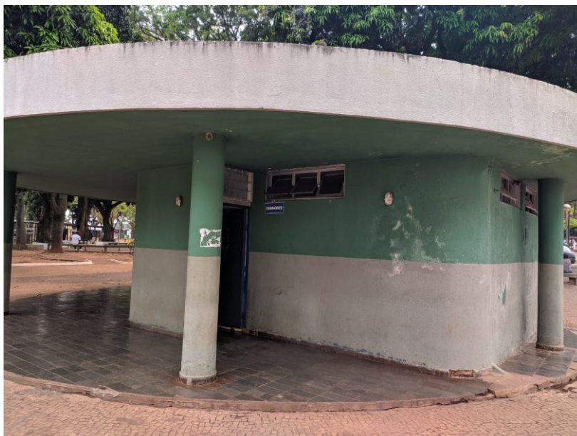
Figura 12: Sanitários públicos da Praça Sérgio Pacheco. (Fonte: Autor).
