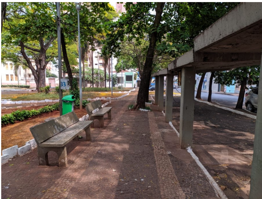
Figura 4: Mobiliário urbano da Praça Adolfo Fonseca. (Fonte: Autor).
