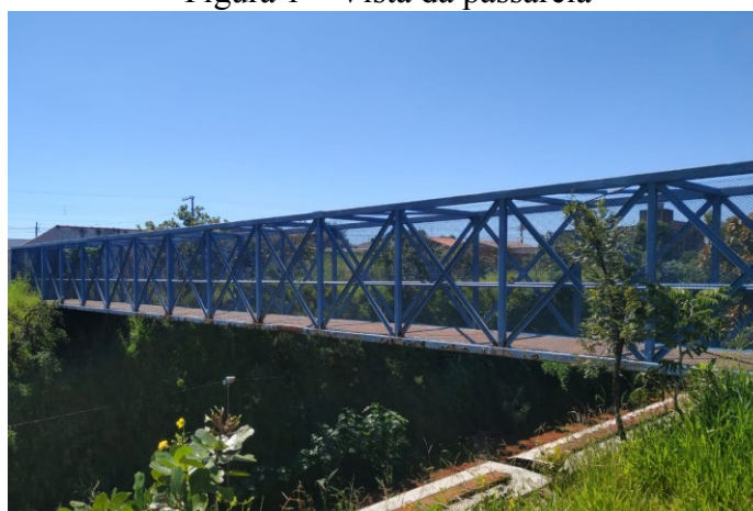
Figura 1 – Vista da passarela
