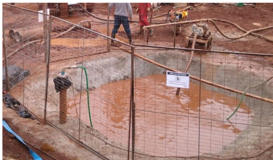
Figura 23 – Poço para reuso de água e captação durante a perfuração.
