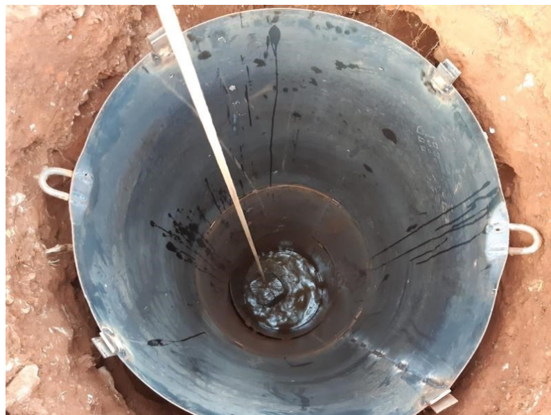
Figura 14 – Nível do lençol freático após 15 dias de rebaixamento.
