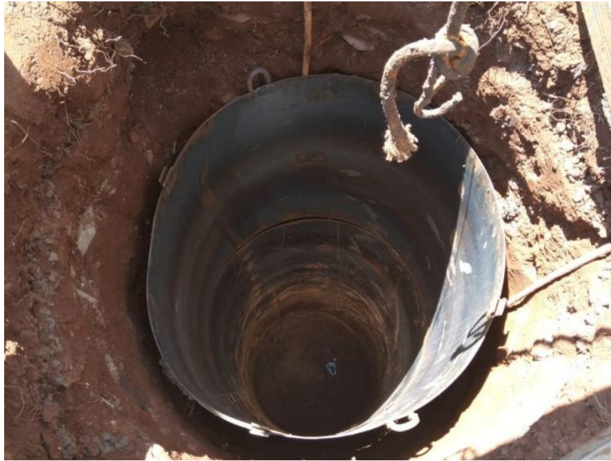
Figura 13 – Início da escavação dos tubulões de periferia.
