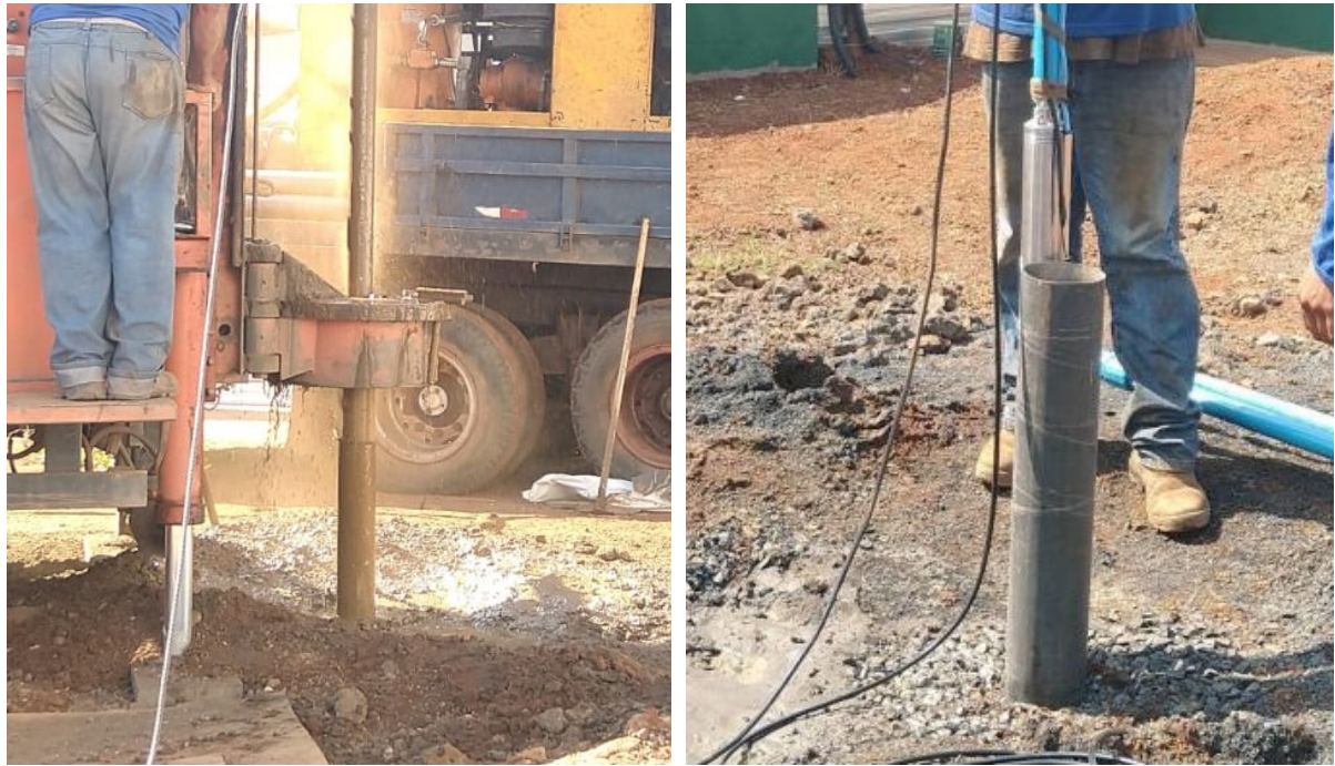
Figura 11 – Perfuração e implantação da bomba submersa no poço perfurado.
