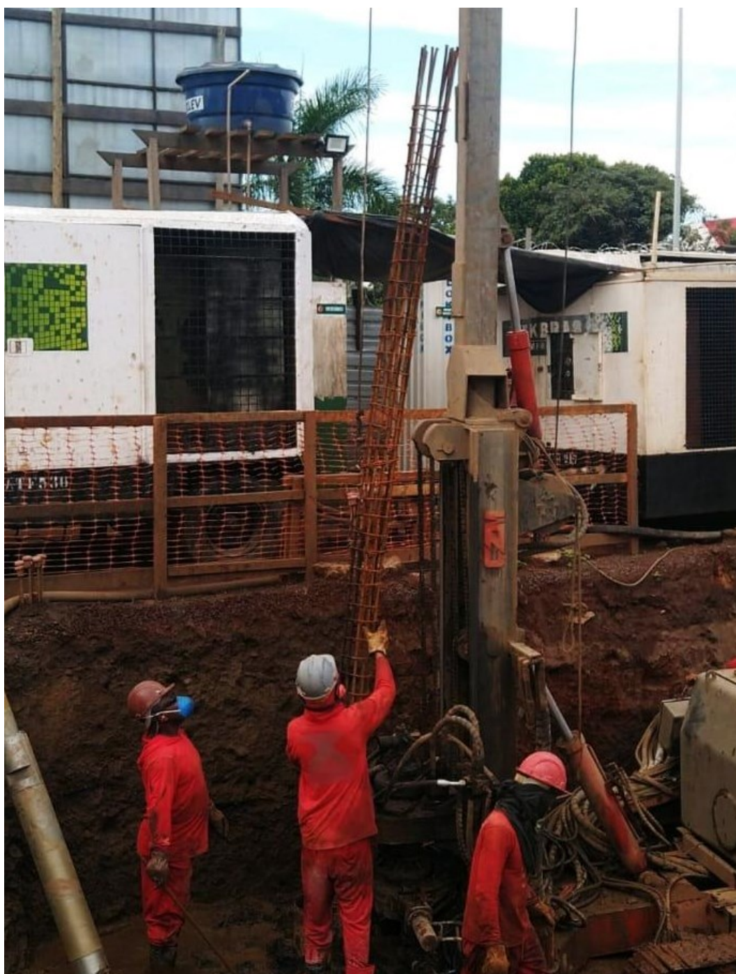
Figura 25 – Execução de estaca raiz – Introdução da armadura.
