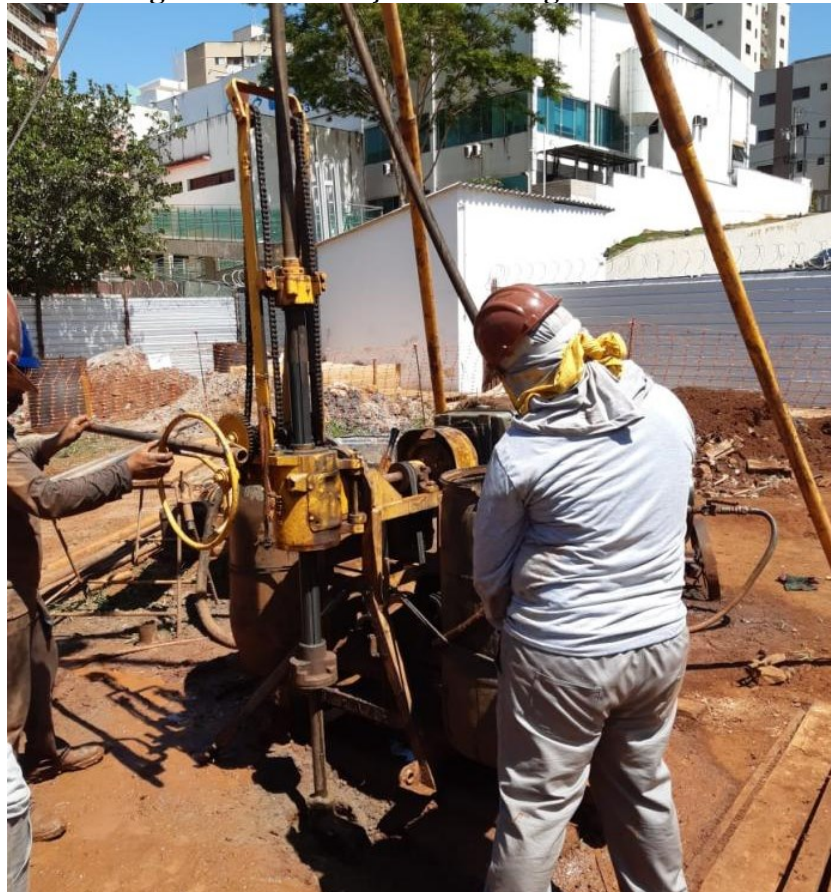
Figura 15 – Execução de sondagem rotativa.
