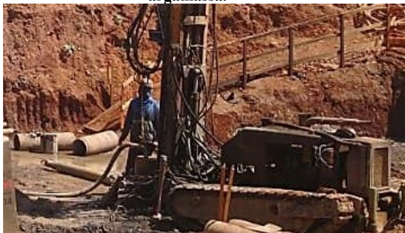
Figura 26 – Execução de estaca raiz – Injeção de preenchimento da estaca com argamassa.
