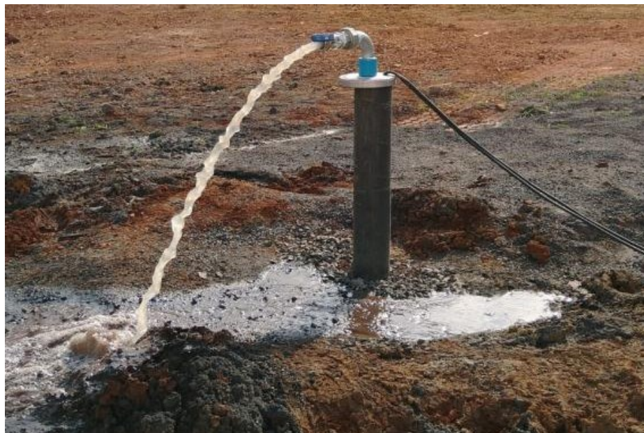
Figura 12 – Sistema de rebaixamento em funcionamento.
