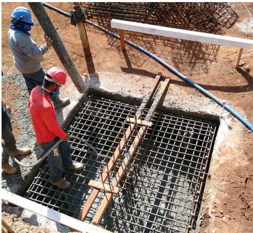
Figura 30 – Concretagem e adensamento de bloco de fundação.
