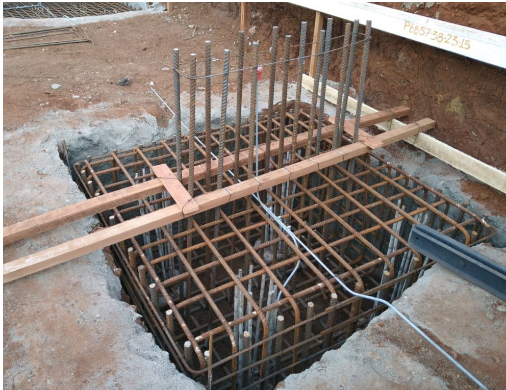
Figura 29 – Bloco armado e preparado para concretagem.
