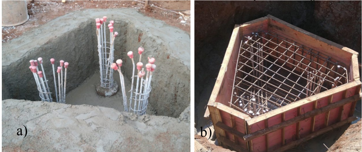
Figura 28 – Blocos escavados e preparados para concretagem – a) Concreto magro para concretagem contra barranco; b) Uso de formas para concretagem
