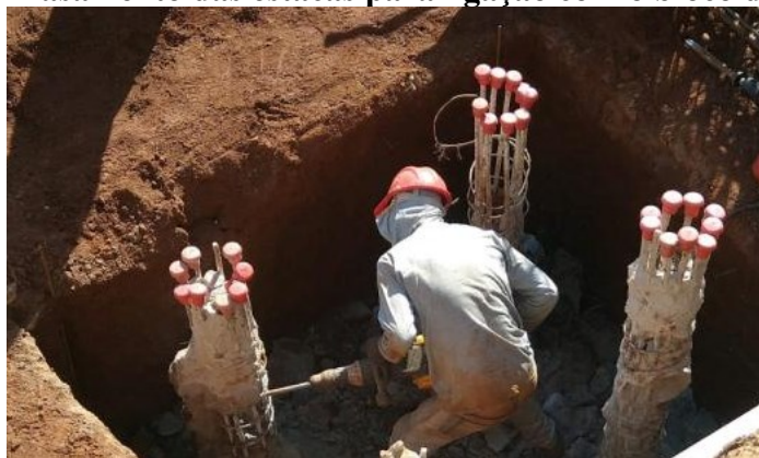
Figura 27 – Arrasamento das estacas para ligação com o bloco de coroamento.
