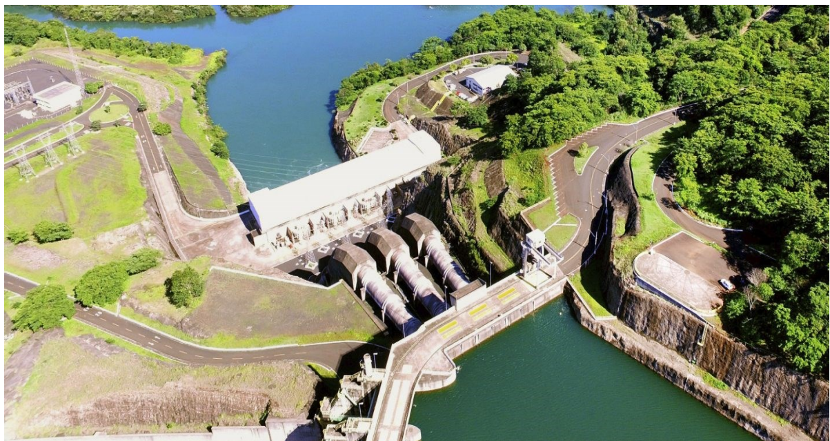
Figura 3.2. Vista superior de UHE Miranda.
