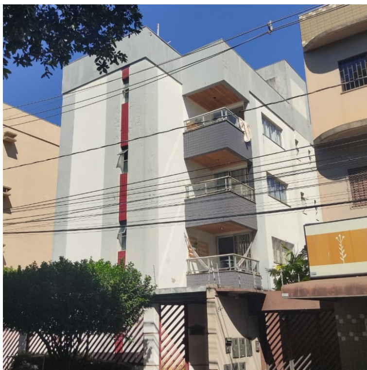
Figura 16 – Fachada da Edificação E.
