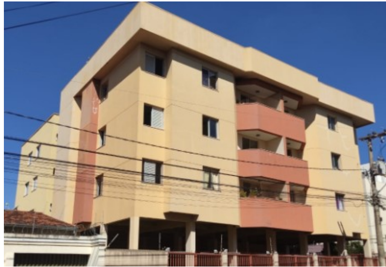
Figura 31- Fachada da Edificação J.
