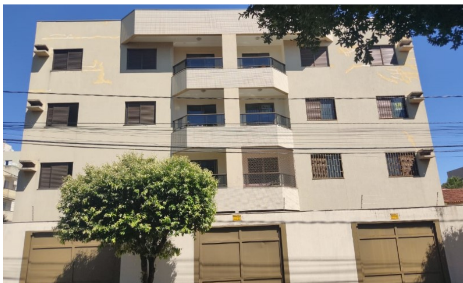
Figura 13 – Fachada da Edificação D.
