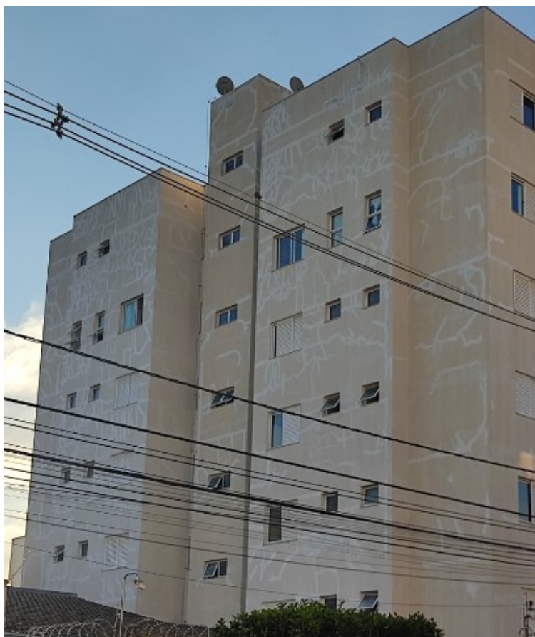
Figura 10 – Fachada da Edificação C.
