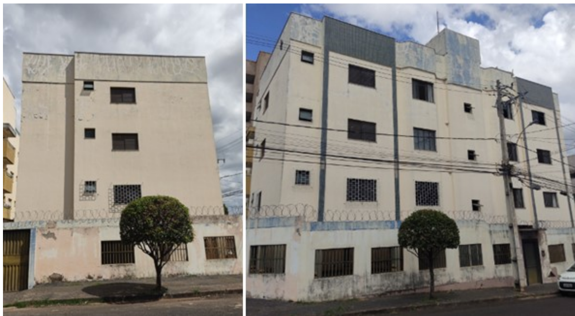
Figura 35 – Fachada da Edificação K.
