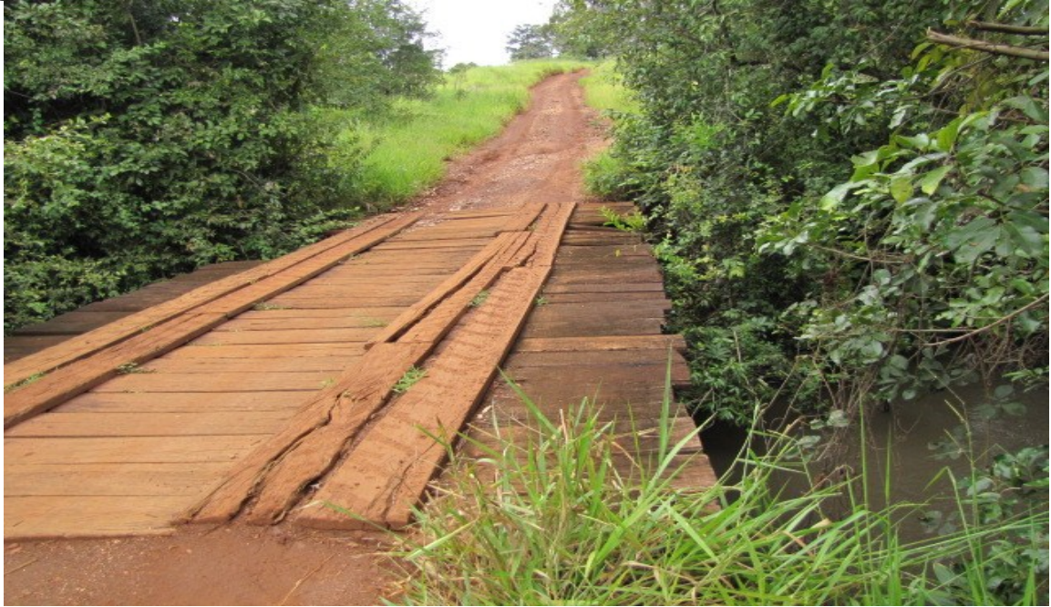
Figura 27 – 6ª ponte rural no Rio das Pedras, Uberlândia – MG, 2017
