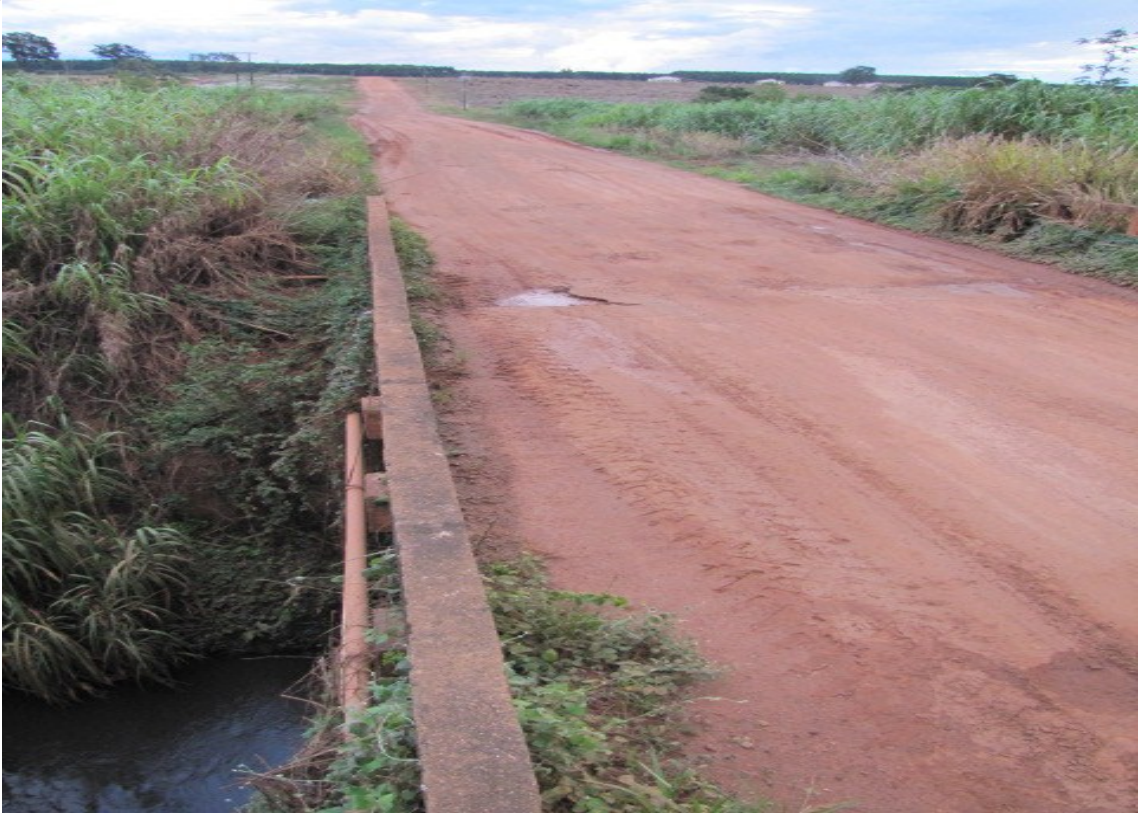
Figura 22 – 2ª ponte rural no Rio das Pedras, Uberlândia – MG, 2017
