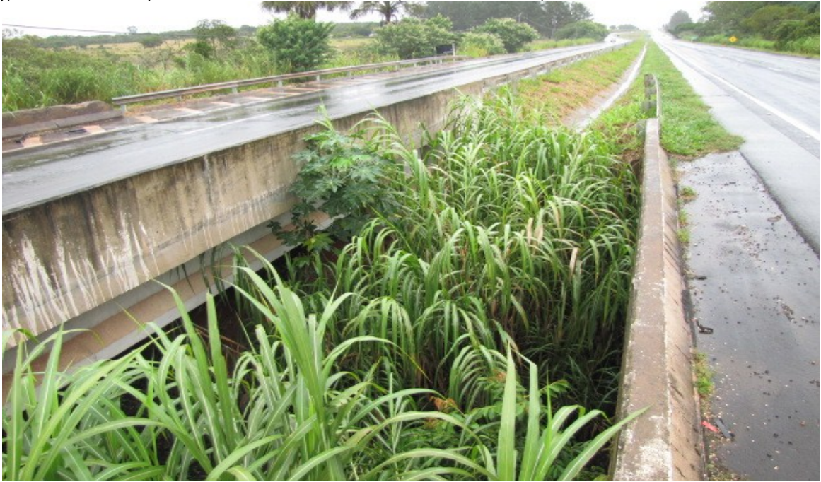
Figura 24 – Ponte dupla da BR-365 no Rio das Pedras, Uberlândia – MG, 2017
