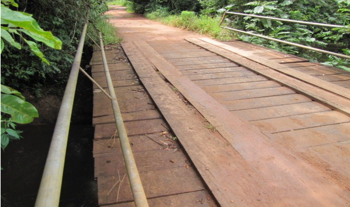
Figura 26 – 5ª ponte rural no Rio das Pedras, Uberlândia – MG, 2017
