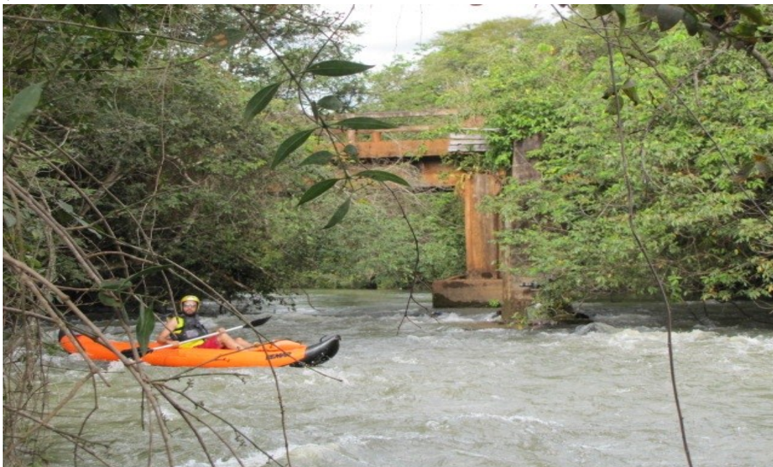
Figura 38 – Navegação por entre as ruínas da antiga ponte de Arame no Rio Uberabinha, Uberlândia – MG, 2017
