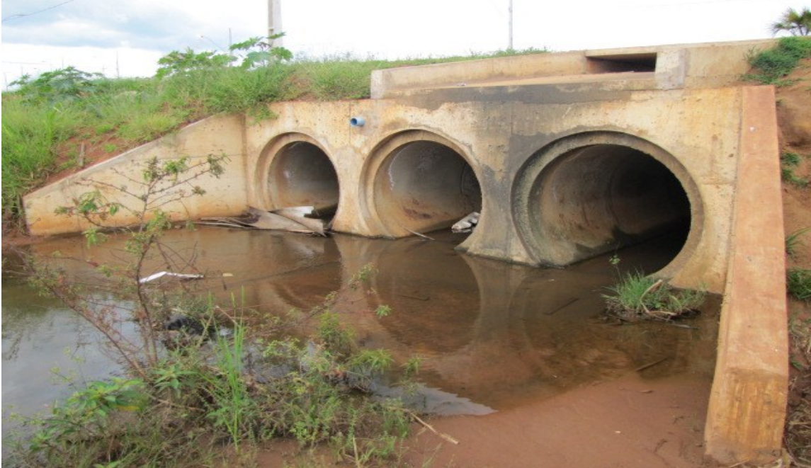
Figura 19 – 1ª canalização no Rio das Pedras, Uberlândia – MG, 2017
