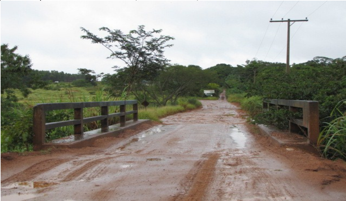
Figura 23 – 3ª ponte rural no Rio das Pedras, Uberlândia – MG, 2017
