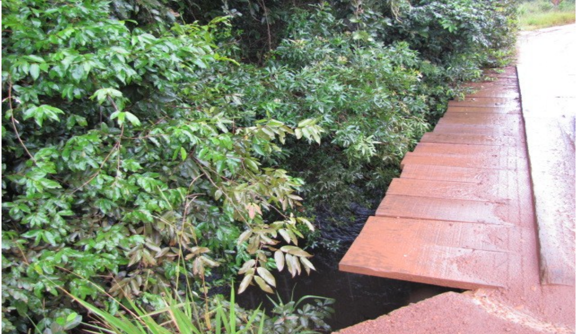
Figura 25 – 4ª ponte rural no Rio das Pedras, Uberlândia – MG, 2017
