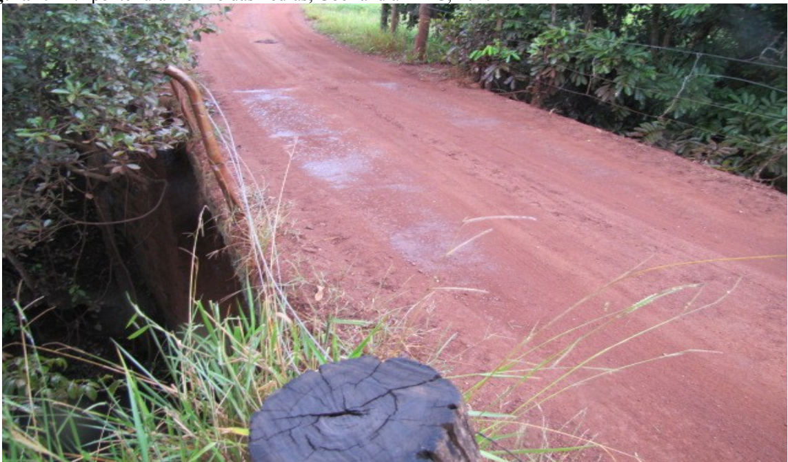
Figura 29 – 7ª ponte rural no Rio das Pedras, Uberlândia – MG, 2017
