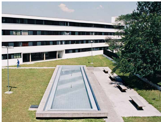
Figura 29 Vista do edifício para o espelho d'água Fonte: Vigliecca
