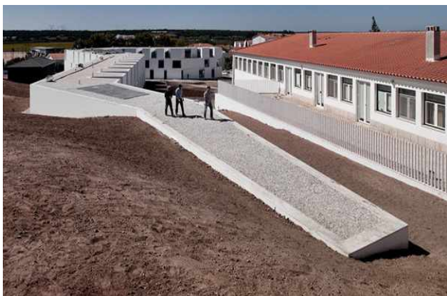
Figura 12 Cobertura transitável graças à implantação do edifício junto à topografia Fonte: Archdaily
