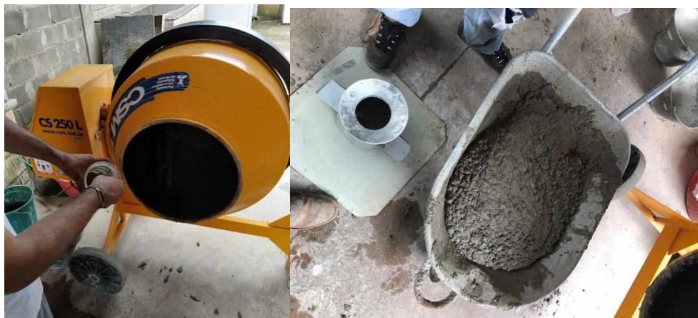
Figura 26a e 26b - Fabricação dos traços de concreto
