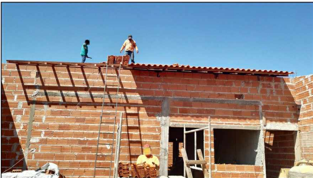
Figura 11: Colocação das telhas
