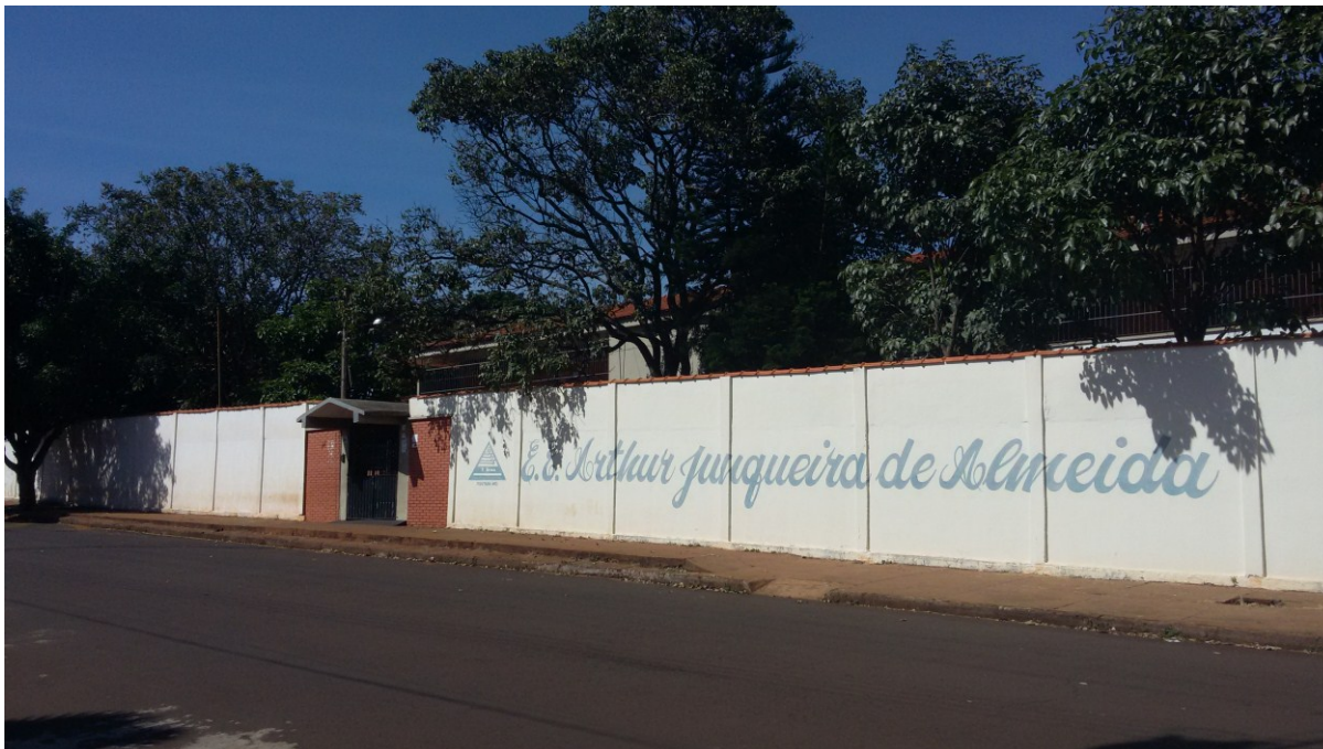
Figura 2 – Vista da Escola Estadual Arthur Junqueira de Almeida
